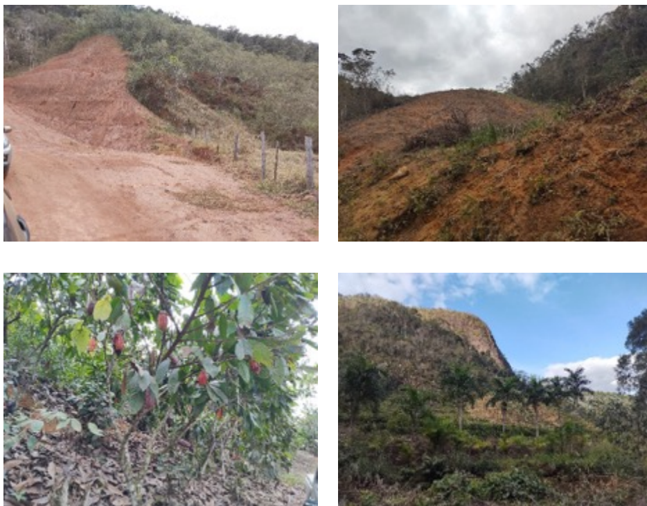
Figura 80. Usos Observados na APA Pico do Goiapaba-Açu (Da esquerda para a direita em sentido horário):1) cortes em taludes para construção de estrada, 2) Solo desnudo para plantação, 3) plantações de cacau, 4) paisagem da Apa com plantações de coco, café nas encostas até as bases dos afloramentos rochosos e plantações à beira dos córregos: Foto: Marcos da Costa Martins, 27/06/2022.
