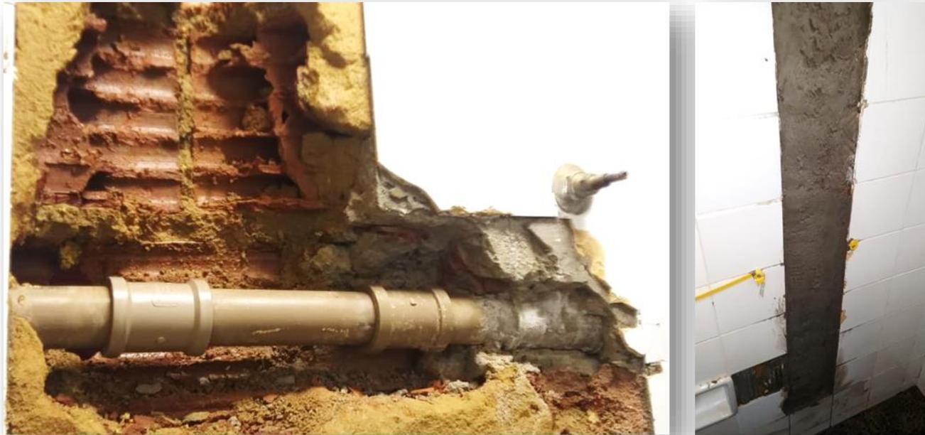
Figura 5 - Manutenção hidrossanitárias nos banheiros do prédio 1.
