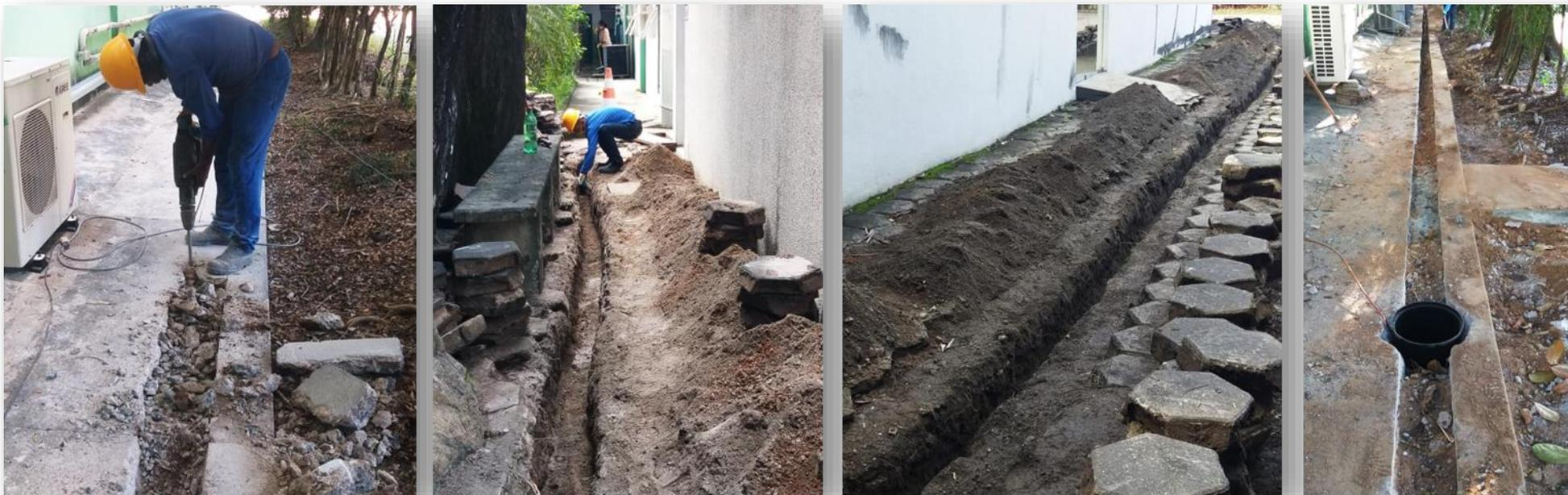
Figura 2 - Execução de aterramento do Prédio 1.
