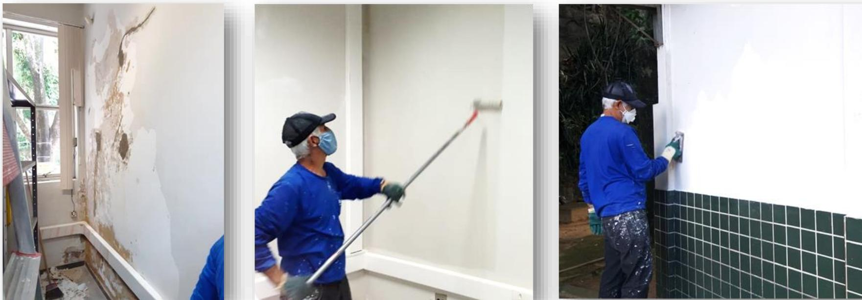
Figura 1 - Atividade de revitalização interna e externa com pequenos reparos e pintura das estruturas.
