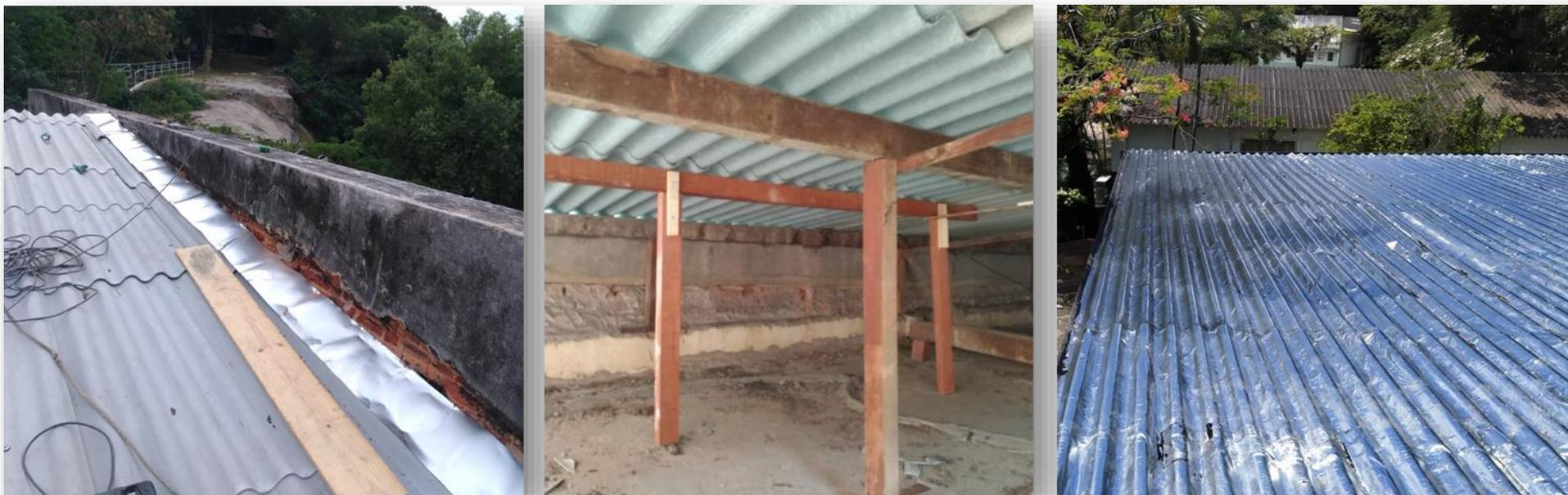
Figura 4 - Troca de telhas, impermeabilização e reforma estrutural no telhado do prédio 1 e impermeabilização do telhado do prédio da Fiscalização
