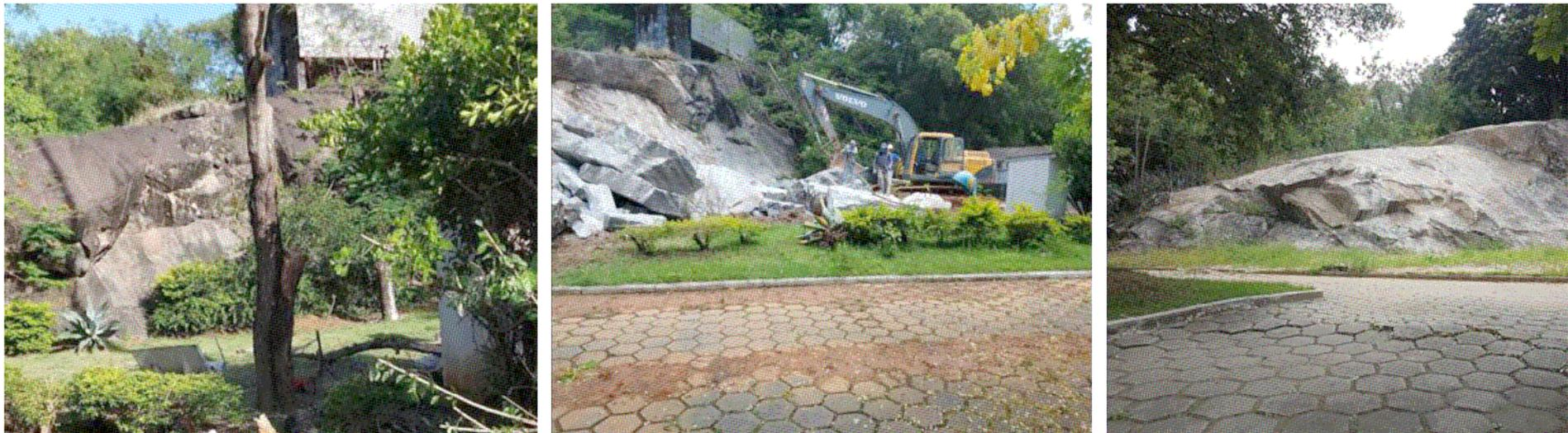
Figura 05. Maciço rochoso antes, durante e após a remoção da porção de risco.
