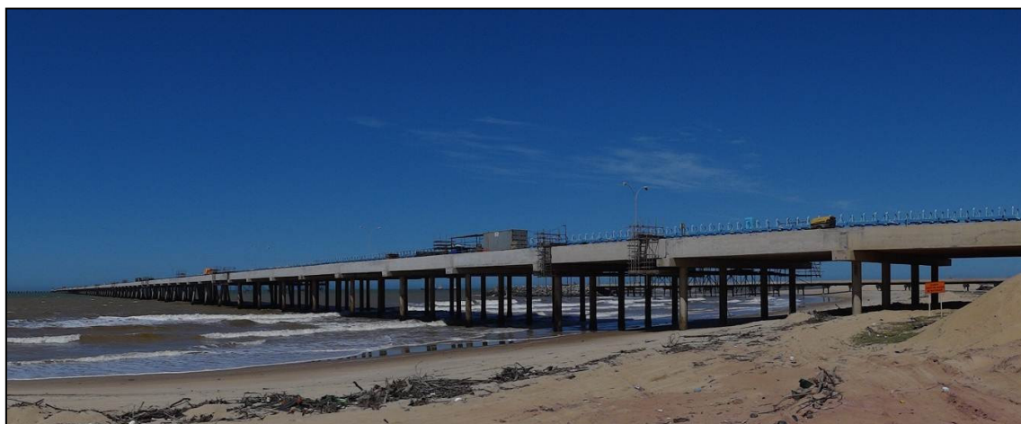
Figura 5-7: Exemplo de obra com estrutura discreta, fixada com estacas pré-moldadas.
