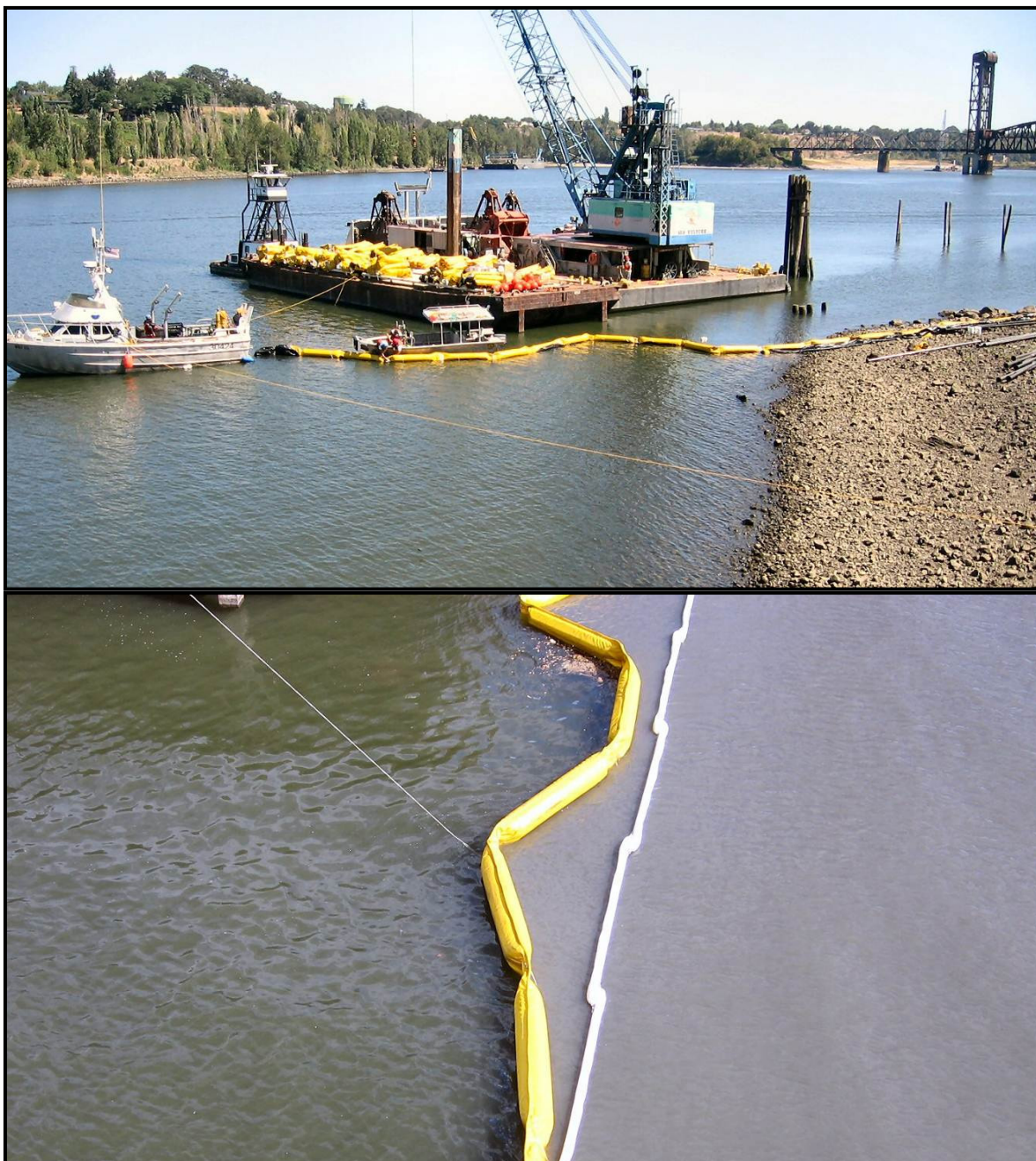
Figura 5-21: Modelo de barreira de proteção ( silt curtain ou cortina de silte) adotada em dragagem nos Estados Unidos. O contraste de cores entre os dois lados da barreira evidencia a eficácia da barreira na contenção da pluma de sedimentos gerada por uma dragagem de fundo lamoso (Fonte: EPA, 2009).
