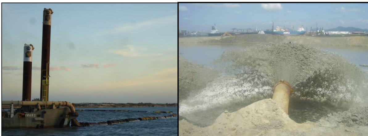
Figura 5-18: Exemplos de dragagem com sucção e recalque em terra.
