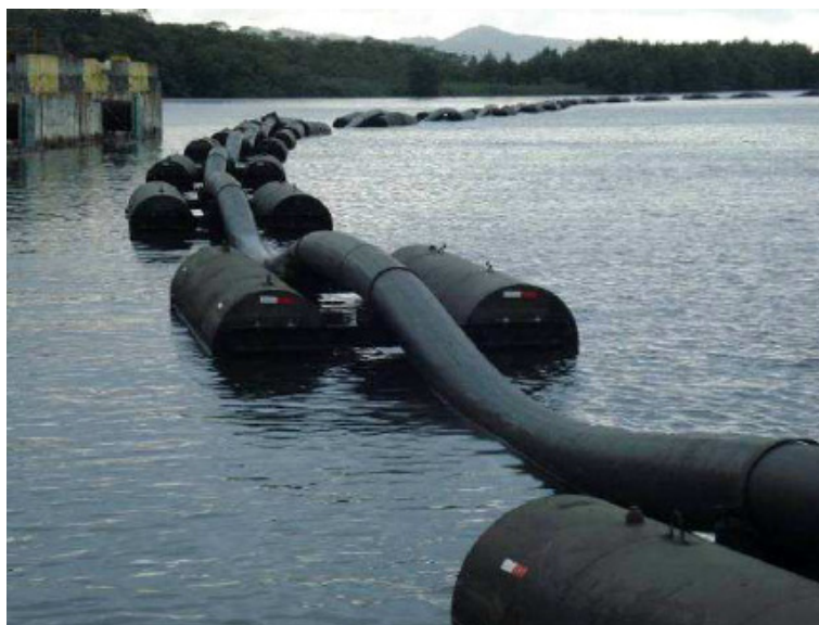
Figura 2-18: Exemplo de encaminhamento por recalque de material dragado.
