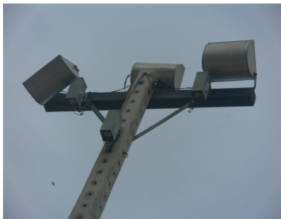
Figura 2-33: Sistema de iluminação formado por luminária fechada tipo projetor, em área de prática de esportes justaposta ao litoral do município de Marataízes.
