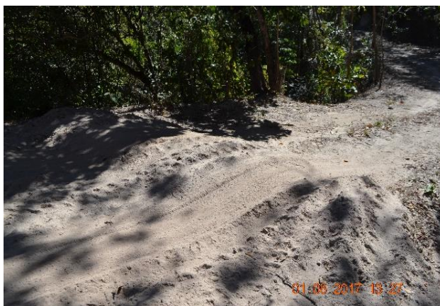
Foto 1-1: Exemplo de camalhão construído em via de acesso. Fonte: Acervo Dossel, 2017.
