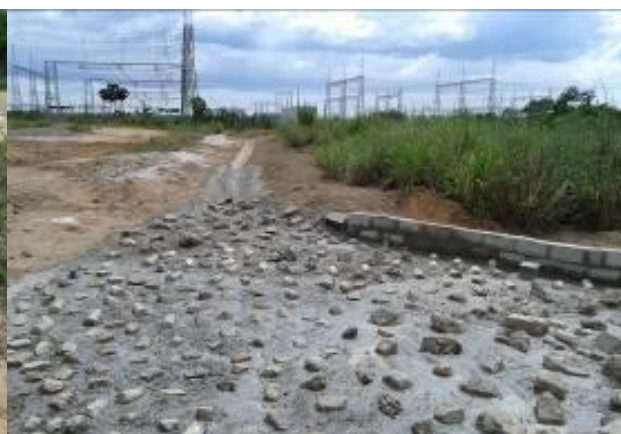
Foto 1-16: Fim da sarjeta de escoamento em área de bota-fora. Fonte: Acervo Dossel, 2015.
