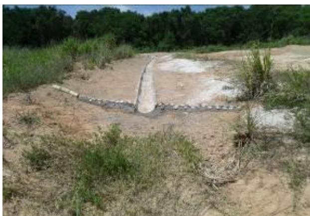
Foto 1-15: Início de sarjeta de escoamento em área de bota-fora. Fonte: Acervo Dossel, 2015.
