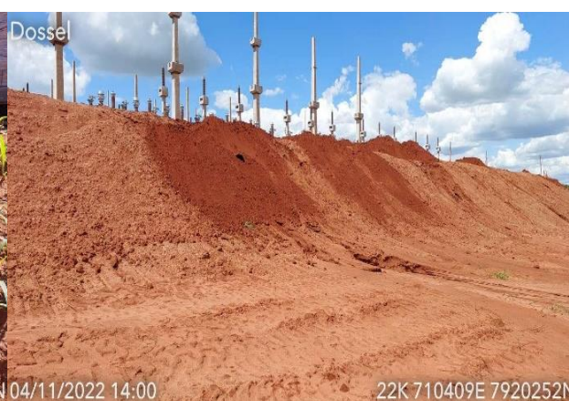
Foto 1-18: Área de talude reconformado após aplicação da primeira hidrossemeadura. Fonte: Acervo Dossel, 2022.
