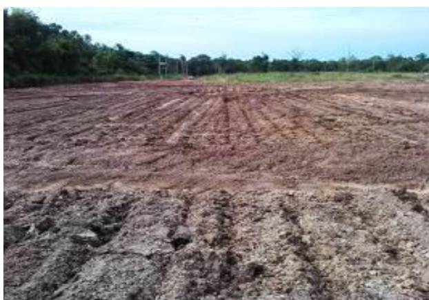
Foto 1-9: Área de canteiro de obras desmobilizado. Escarificação do solo e semeadura de capim-quicuiu ( Pennisetum clandestinum ). Fonte: Acervo Dossel, 2015.
