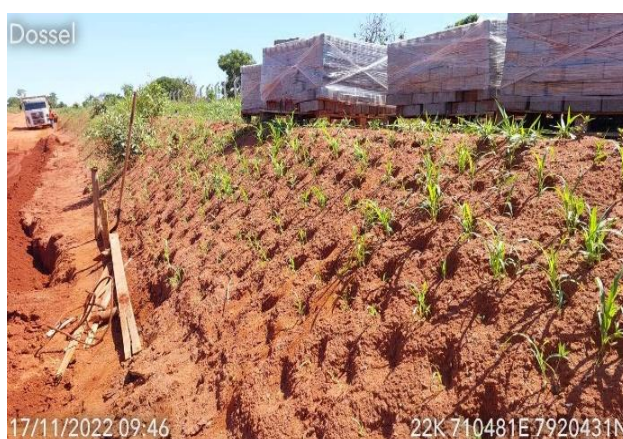
Foto 1-17: Detalhe de talude com vegetação em desenvolvimento. Fonte: Acervo Dossel, 2022.
