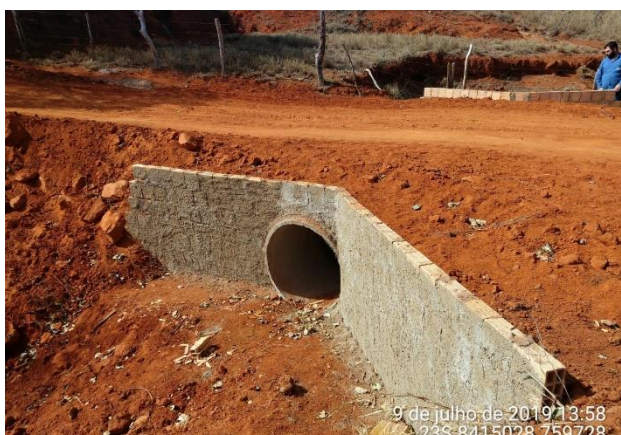
Foto 1-3: Implantação de bueiro em acesso. Fonte: Acervo Dossel, 2019.
