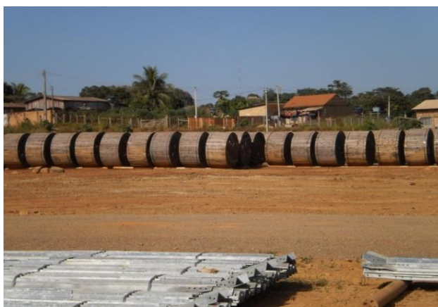
Foto 1-7: Canteiro de obras implantado em zona urbana. Fonte: Acervo Dossel, 2014.
