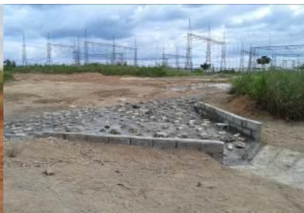
Foto 1-14: Entrada de canaleta com pedras de mão e concreto, para direcionamento do fluxo d'água em área de bota-fora. Fonte: Acervo Dossel, 2015.
