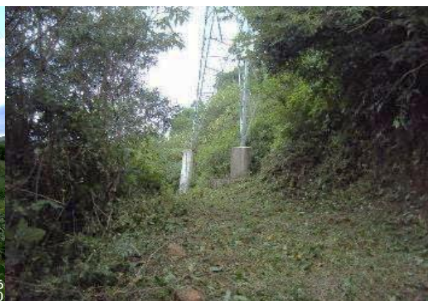
Foto 1-6: Praça de torre autoportante. Fonte: Acervo Dossel, 2020.
