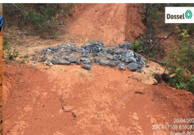
Foto 1-4: Passagem molhada em acesso. Fonte: Acervo Dossel, 2020.
