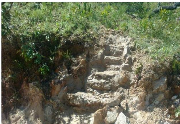
Foto 1.1-5: Exemplo de escada hidráulica construída com pedras de mão e solo-cimento. Fonte: Acervo Dossel, 2017.
