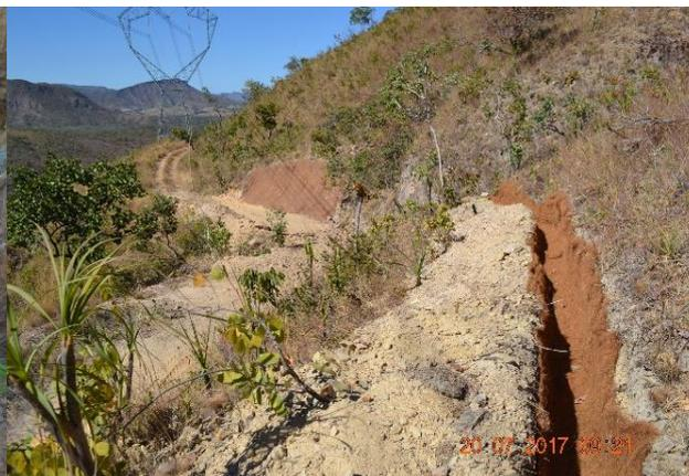
Foto 1.1-4: Exemplo de canaleta de crista com biomanta instalada em grande talude, compondo o sistema de drenagem pluvial com solos frágeis e promovendo a revegetação. Fonte: Acervo Dossel, 2017.
