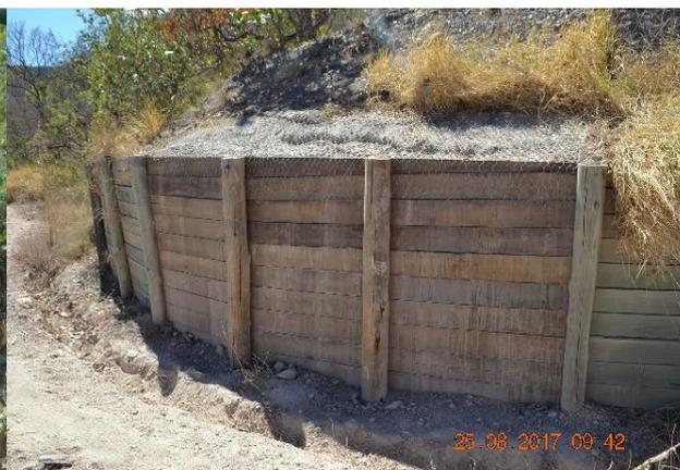
Foto 1.1-6: Exemplo de paliçada para conter desmoronamento de sedimento do talude. Fonte: Acervo Dossel, 2017.
