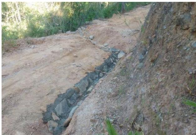
Foto 1.1-3: Exemplo de um sistema de drenagem pluvial (sarjeta) instalado em uma via de acesso localizada em terreno com alta declividade. Fonte: Acervo Dossel, 2017.
