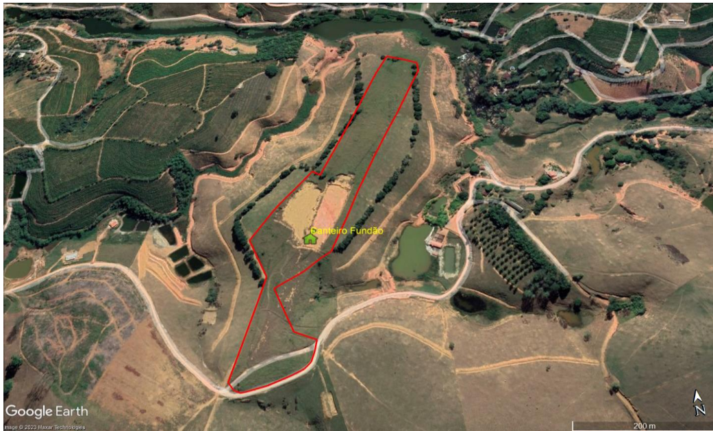
Figura 3 – Imagens da área pretendida para instalação do Canteiro de obras Fundão - ES.
