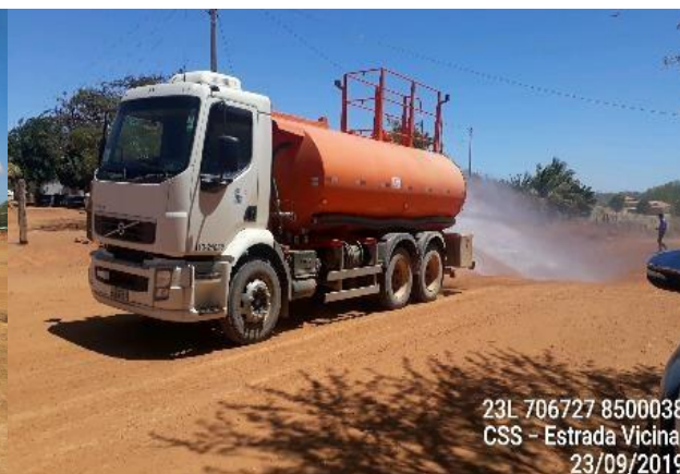
Foto 1-2: Umedecção em via de acesso não pavimentada. Fonte: Acervo Dossel, 2019.
