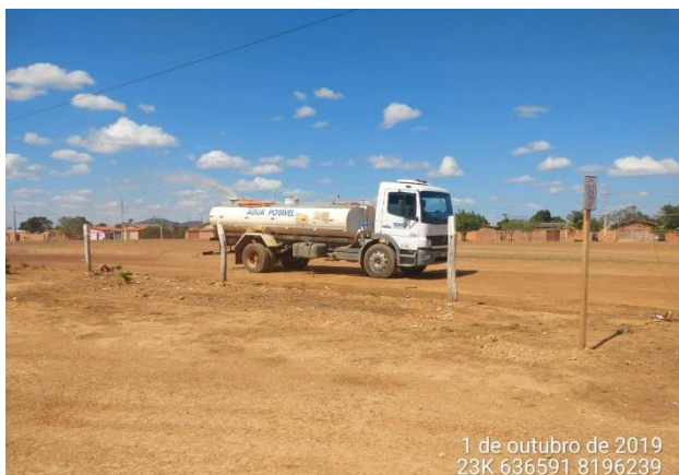
Foto 1-1: Umedecção em via de acesso não pavimentada. Fonte: Acervo Dossel, 2019.
