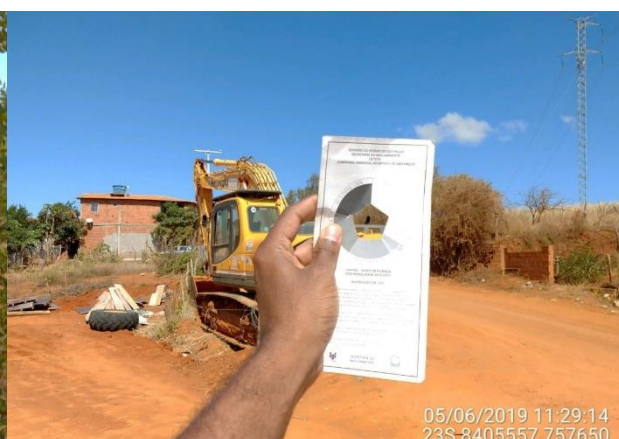
Foto 1-8: Monitoramento de fumaça preta (escala de Ringelmann). Fonte: Acervo Dossel, 2019.
