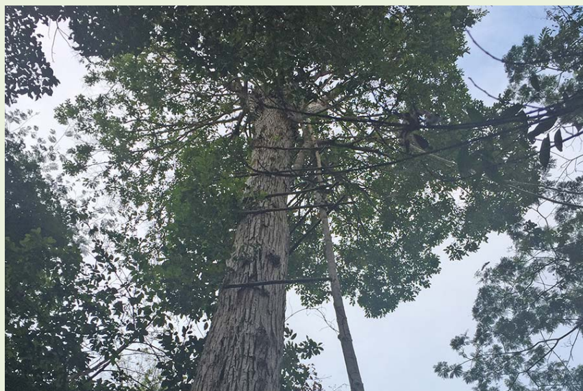
Figura 7.2.1.2.3 -12 – Degraus pregados e amarrados em árvore de grande porte na Estação 6.
