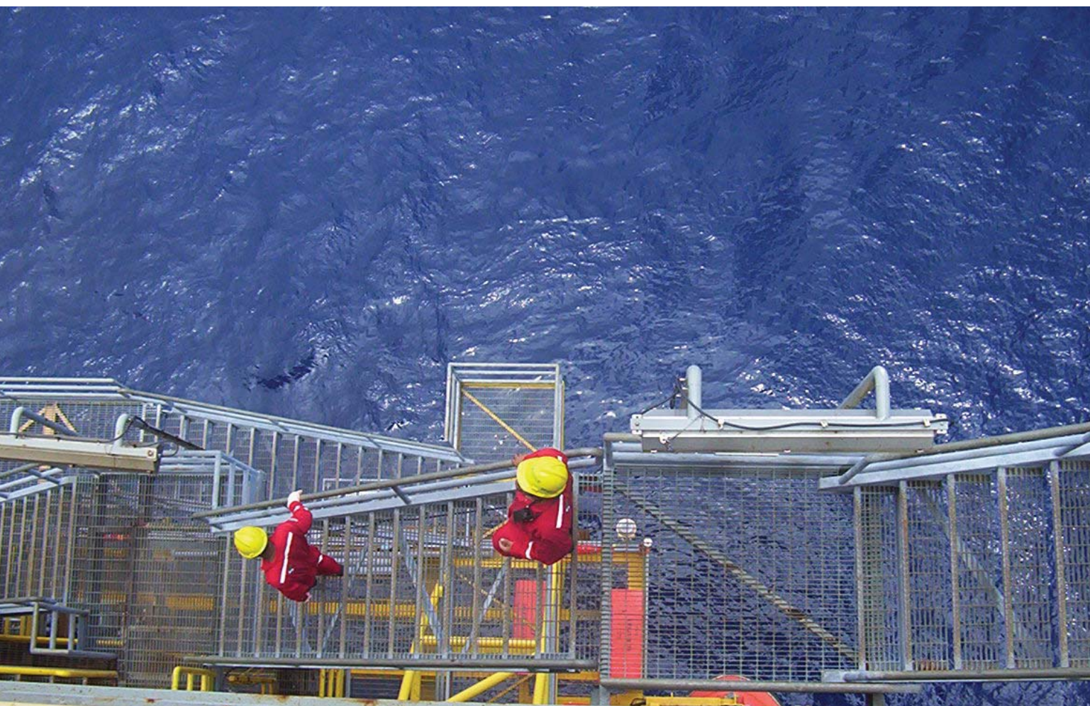
Figura 25 - Trabalhadores vistoriando unidade em alto mar.
