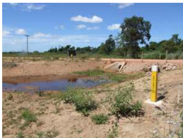
Travessia de água e alagado próximo à via e ao gasoduto Cacimbas-Vitória
