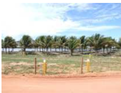
Via junto ao gasoduto Cacimbas Vitória, Coqueiral e ao fundo lagoa.
