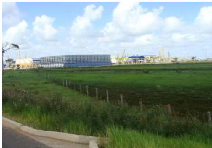
Unidade de Tratamento de Gás, em Cacimbas
