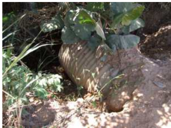
Tubulação de drenagem sob a via.
