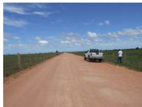
Detalhe da medição da largura da alternativa 1, com 10,8 metros de largura.
