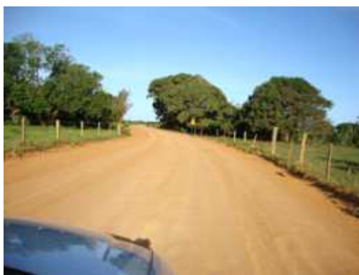
Perspectiva de trecho da rodovia ES-010, próximo à Cacimbas. Observa-se a intensa compactação dos solos e materiais constituintes do leito da pista e suas margens.
