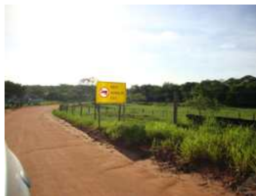
Trecho da rodovia ES-248 nas proximidades do distrito de Povoação-Linhares.
