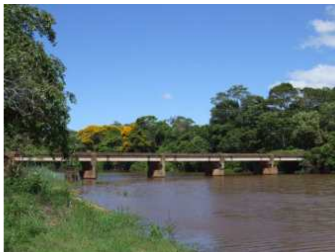
Área de travessia do rio Monsarás.
