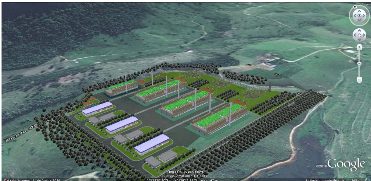
Figura 1.1.1: Arranjo espacial do Complexo Termelétrico Vila Velha no site mostrando as usinas I, II, III e IV.
