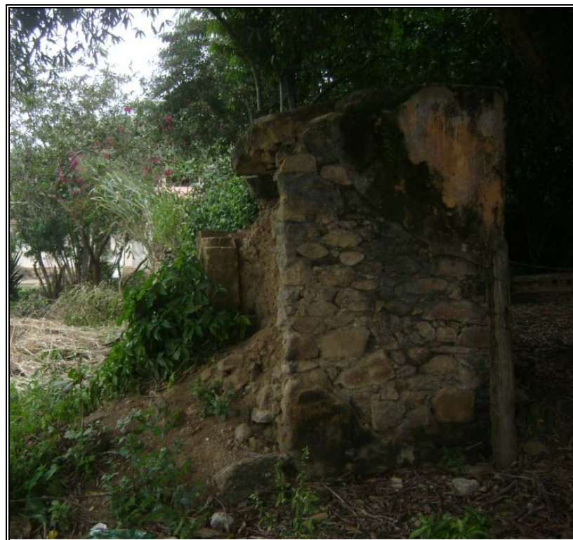
Figura 3.14.6 - Detalhe de estrutura de antiga escadaria (Fonte: COSTA, 2010).
