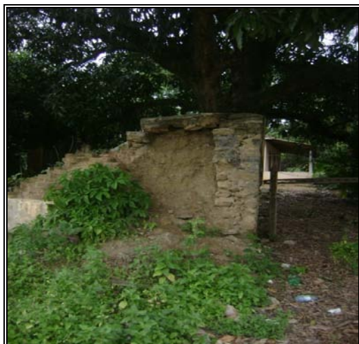
Figura 3.14.7 - Vê-se que a antiga escada de acesso a residência recebe preenchimento com sedimento possivelmente do quintal (Fonte: COSTA, 2010).
