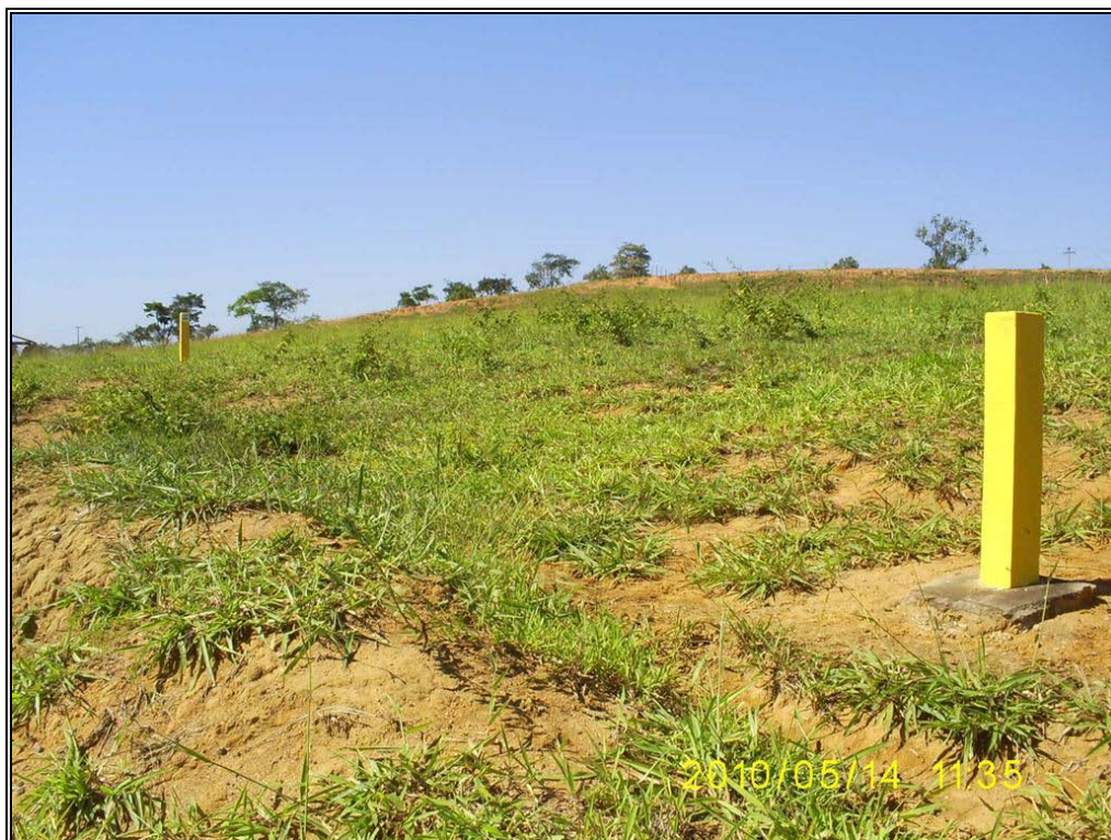
Figura 1.8.6 – Marco na Fazenda Ilha do Sereno mostrando o caminhamento do gasoduto da BR Distribuidora.
