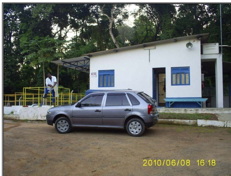
Figura 3.5.9 – Aspecto da Estação de Tratamento de Água do bairro Jucu, localizada nas imediações deste distrito.
