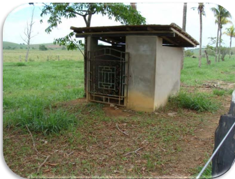
Figura 15 - Local do poço artesiano
