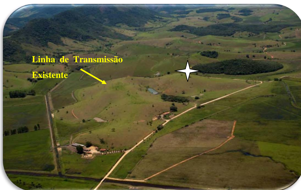
Figura 12 – Detalhes da área da UTE Santa Júlia I
