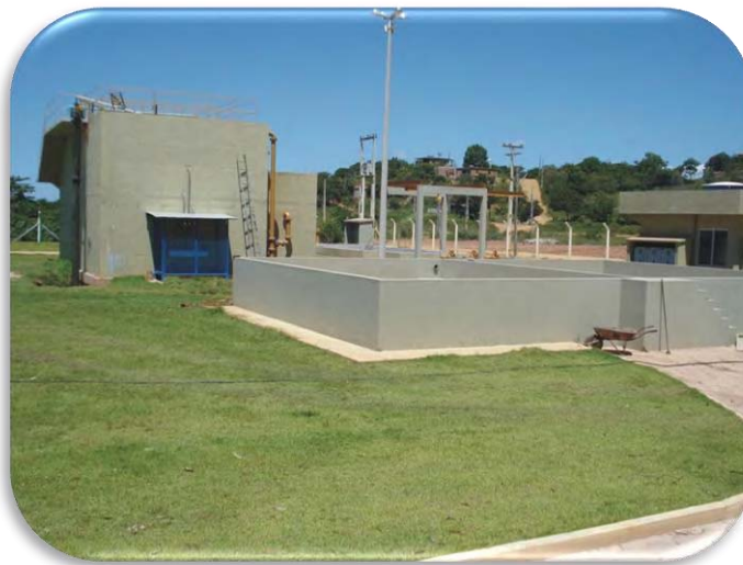
Figura 41 - Nova Estação de Tratamento de Esgoto de Anchieta http://www.es.gov.br/site/files/arquivos/imagem/novaETEAnchietasede01.jpg
