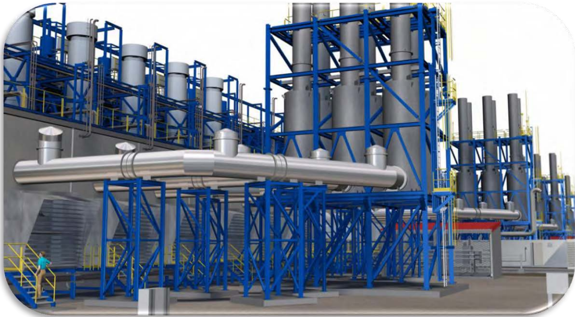
Figura 8 – Vista típica do sistema de exaustão de gases Fonte: WÄRTSILÄ
