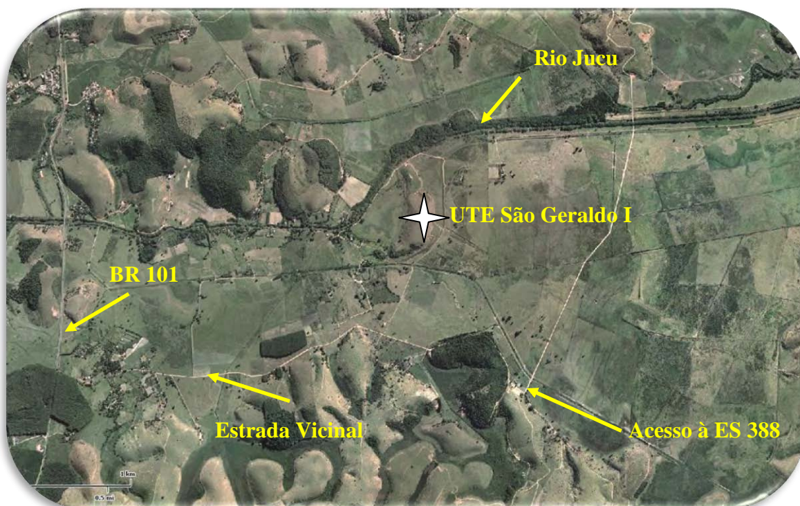
Figura 11 - Vista geral da área da UTE São Geraldo I
