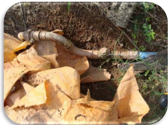
Figura 14 – Encanamento do poço artesiano
