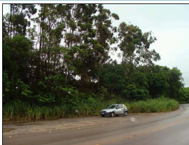
E: Área do canteiro de obras, visão lateral.
