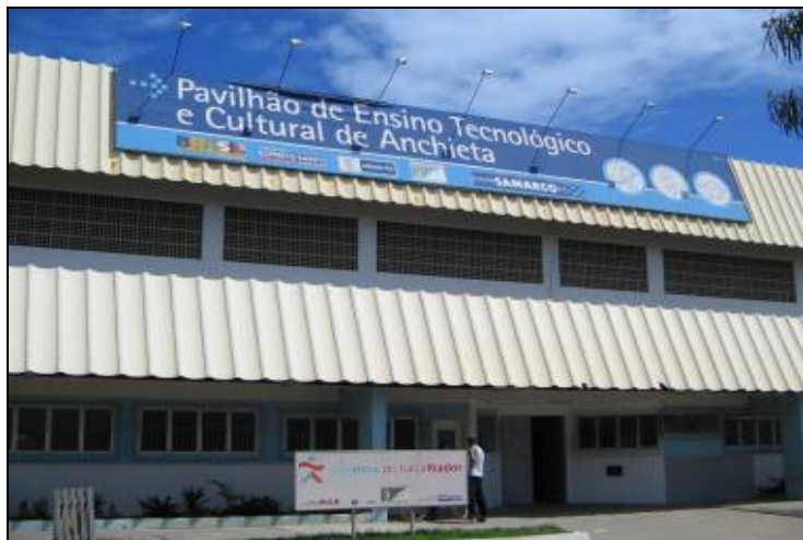
Figura 3-14: Pavilhão de Ensino Tecnológico de Anchieta.
