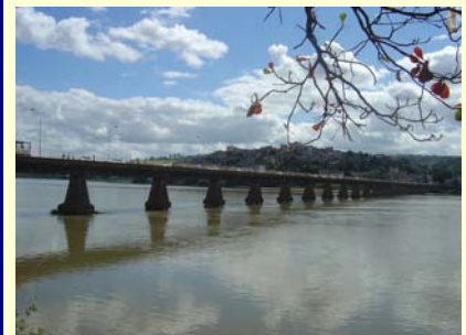
Primeira Ponte de Colatina.
