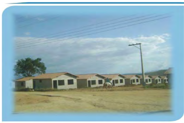
Figura 26: Casas populares no bairro, em construção.
