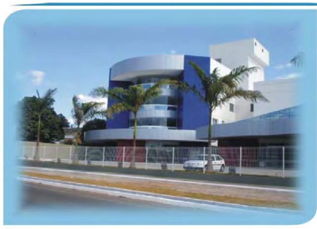
Figura 30: São Bernardo Apart Hospital.
