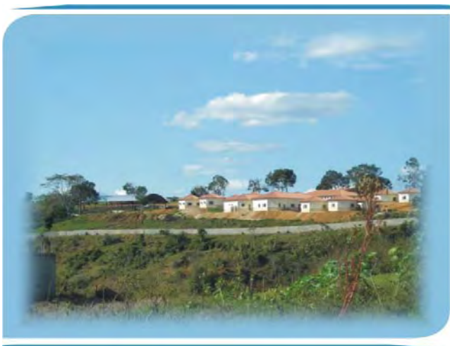
Figura 27: Escola em construção no bairro.
