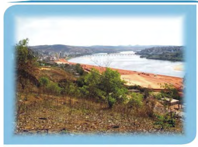
Figura 41: Foto das obras de ampliação da Avenida Beira Rio.
