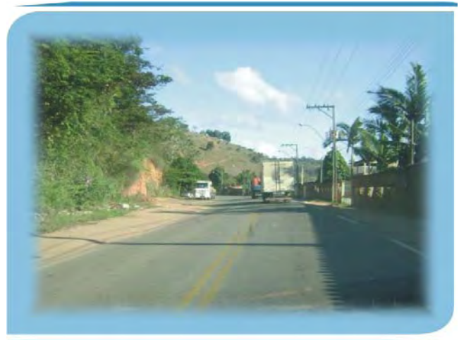
Figura 38: Rodovia ES 080, próxima comunidade de Ponte do Pancas.
