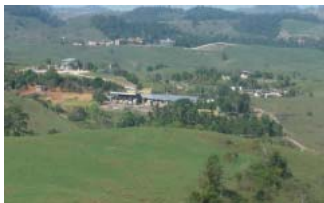
Figura 4.1.11-1 - Vista do terreno do aterro em direção a empresa São Joaquim Ltda
