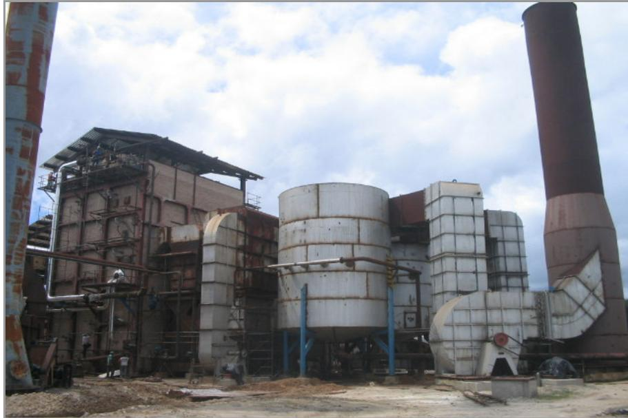
**Figura 6.1.2.1.1-9 – Ilustração de sistema de lavagem de gás de uma caldeira aquatubular**
