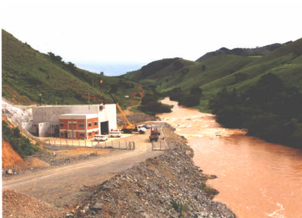
FOTO 29 - Relevo encaixado a montante da barragem, com vários rápidos ou corredeiras surgindo em meio ao leito do rio.
