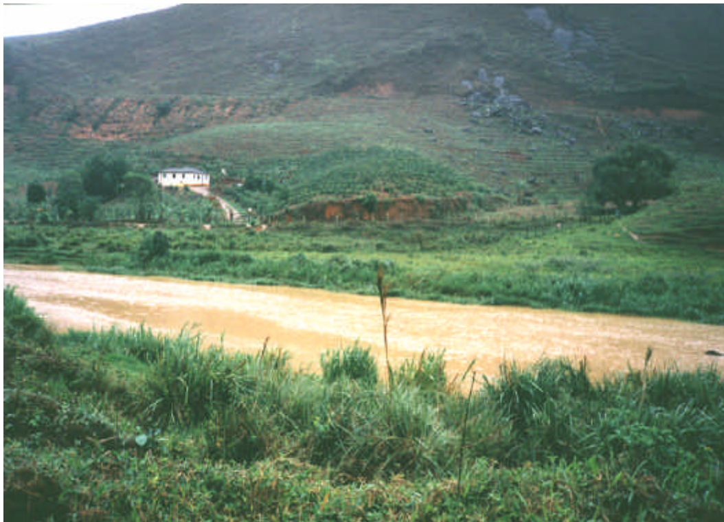
FOTO 03 – Aspectos da área onde vai ser implantado o canal de adução ao túnel adutor. Em decorrência da declividade muito acentuada do local o canal será bastante curto. O emboque do túnel se localiza praticamente junto às margens do reservatório.
