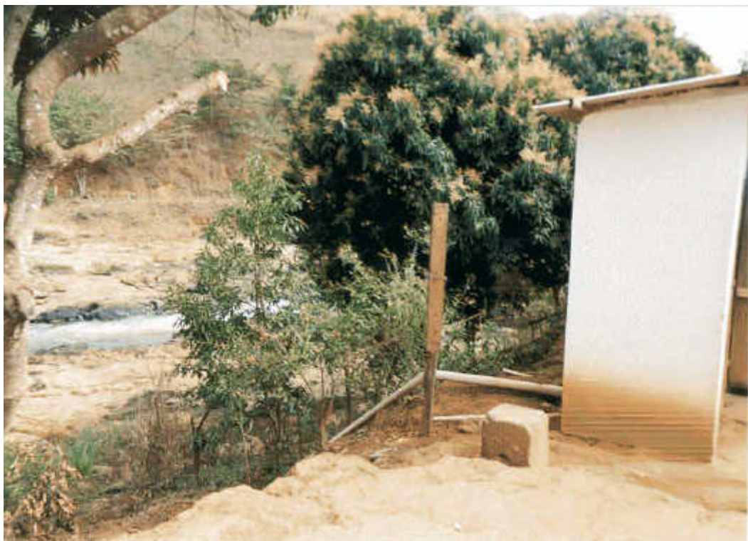
FOTO 47 - Posto fiscal com canalização de esgoto para lançamento no rio Itabapoana
