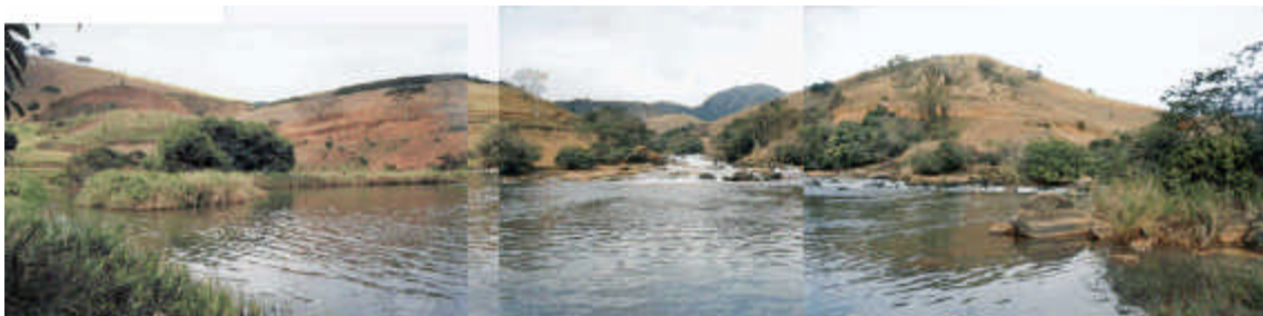
FOTO 57 - Posto de Coleta 03 – entre o Eixo e a Casa de Força.
