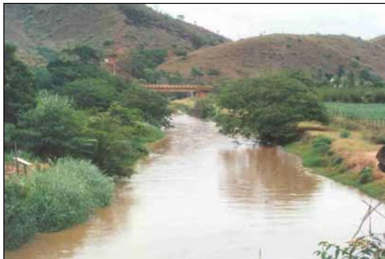
Ponte de concreto sobre o rio Guandu, no final do futuro reservatório.
