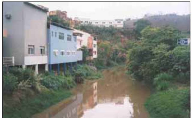
Trecho urbano fortemente impactado pela existência residências nas margens do rio.
