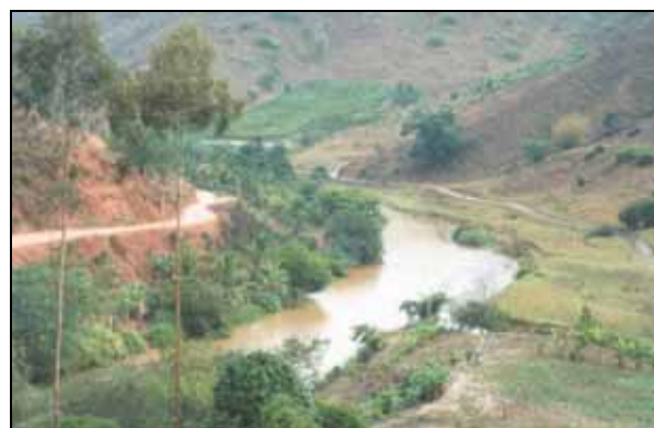
Acesso pela margem esquerda, próximo ao rio.
