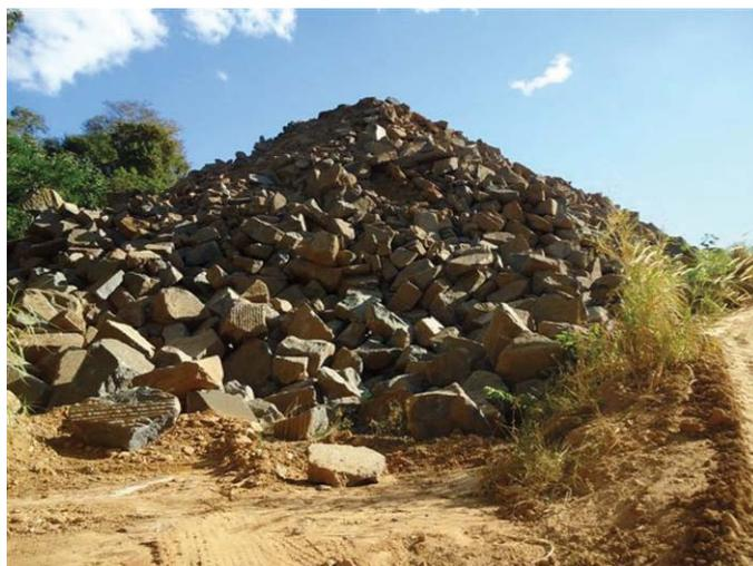
Figura 3-13: Exemplo das rochas que serão utilizadas para a construção do quebra-mar.
