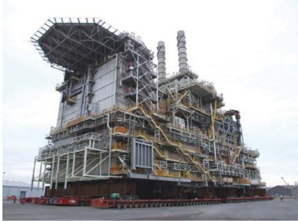
Figura 3-14: Módulos acabados sendo carregados
