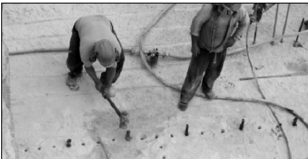
Figura 35. Execução da divisão mecânica por intermédio de cunhas.
