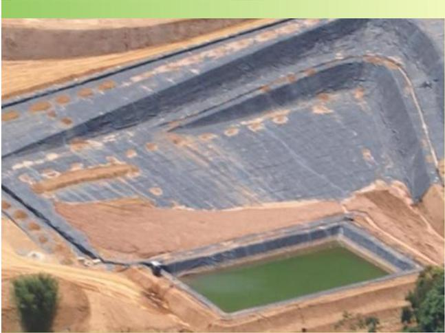
Figura 2: Geomembrana lançada na fundação de um aterro sanitário, apresentando uma camada de proteção
