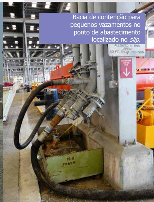
Bacia de contenção para pequenos vazamentos no ponto de abastecimento localizado no *slip*.
