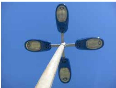
Sistema de iluminação formado por luminária fechada do tipo pétala, com detalhe da luminária com 4 focos luminosos. A área pretendida para implantação do empreendimento pode ser visualizada no círculo vermelho.
