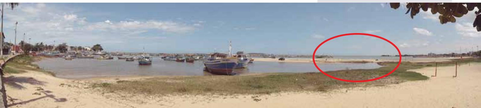
Destaque para o assoreamento visto na praia de Itaipava após construção do molhe Norte do Terminal Pesqueiro. Tal situação impossibilita que a água circule e se renove.
