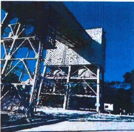
Figuras 15 – Silo de cal dolomítica e calcítica no limite de bateria entre a Arcelor e a Lhoist com acúmulo de pós no piso
