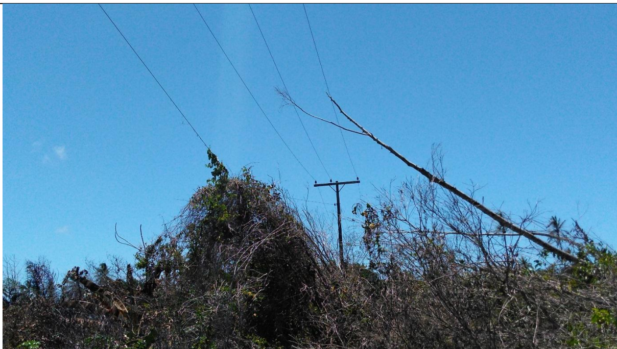
Figura 07: Detalhe da rede de energia elétrica que provocou o incêndio. Vegetação emaranhada na fiação.
