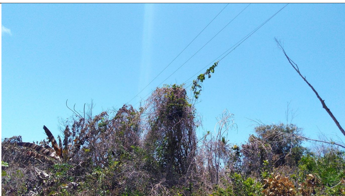
Figura 06: Detalhe da rede de energia elétrica que provocou o incêndio. Vegetação emaranhada na fiação.
