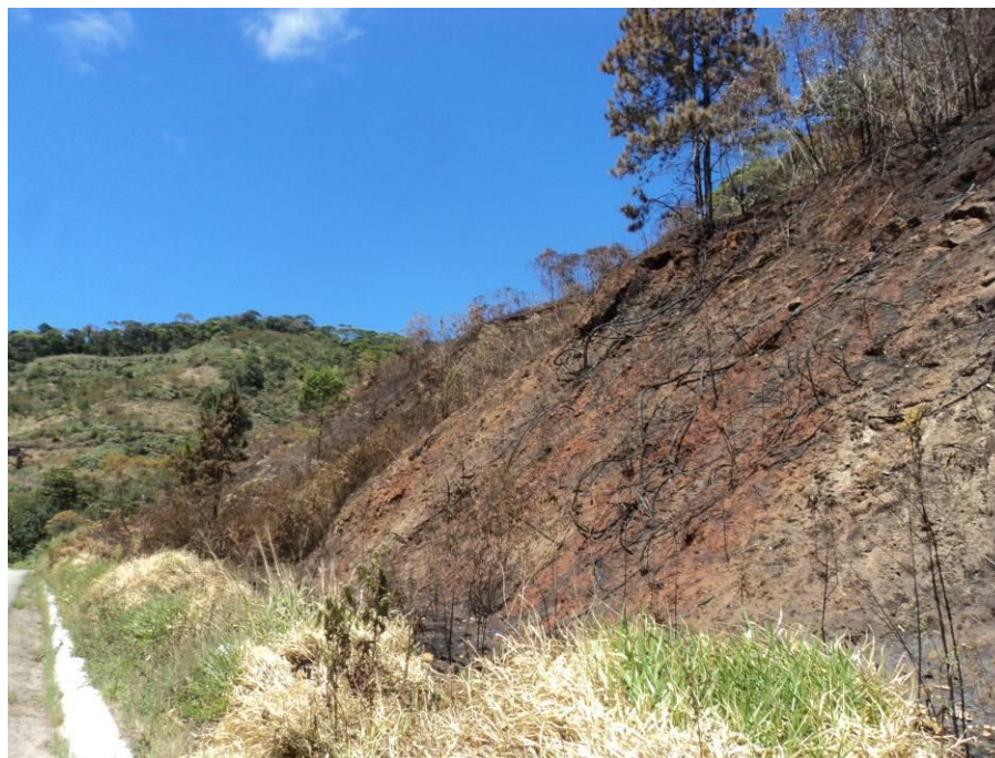
Legenda: Vista do local atingido às margens da BR 262 km 80.
