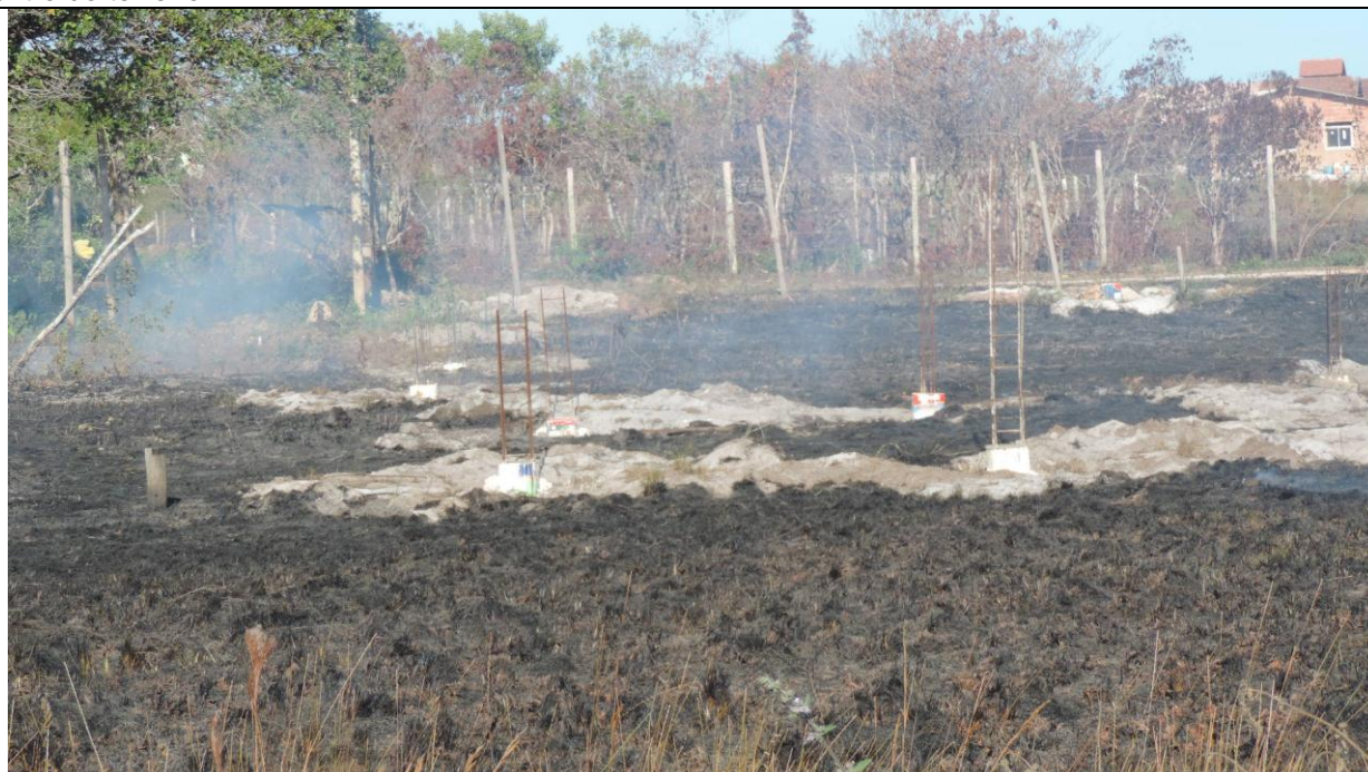
Figura 2: Foto tirada em 16/04/2015, pela TDARH Juliana Dias Salgueiro. Coordenadas UTM: Lon. 353054 Lat. 7726350. Base para construção visualizada dentro do terreno queimado
