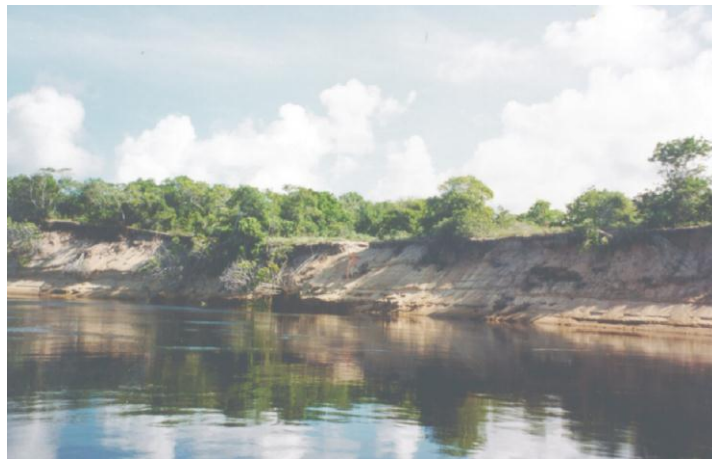
Figura 57 : Destruição natural das margens do rio Itaúnas atingindo a Formação Florestal não Inundável, no Parque Estadual de Itaúnas/ES.
