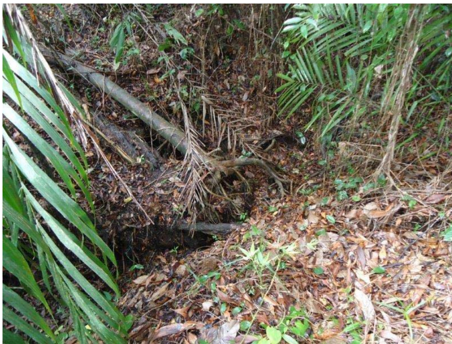
Foto 2.1.4.3-8- P33 e 33-2 - 419268/7944182 – Calha do córrego da Areia em período seco a jusante da estrada vicinal.
