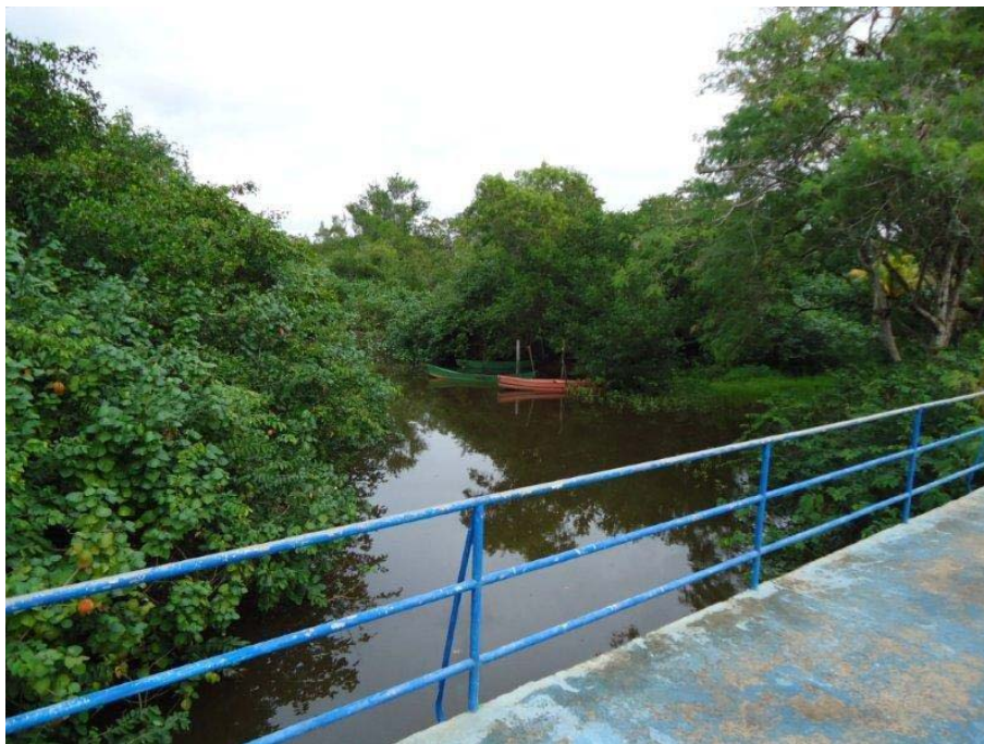
Foto 2.1.4.3-1 - P36 - 421202/7946890 – Córrego São Domingos, a montante da ponte da rodovia Adolpho Serra.
