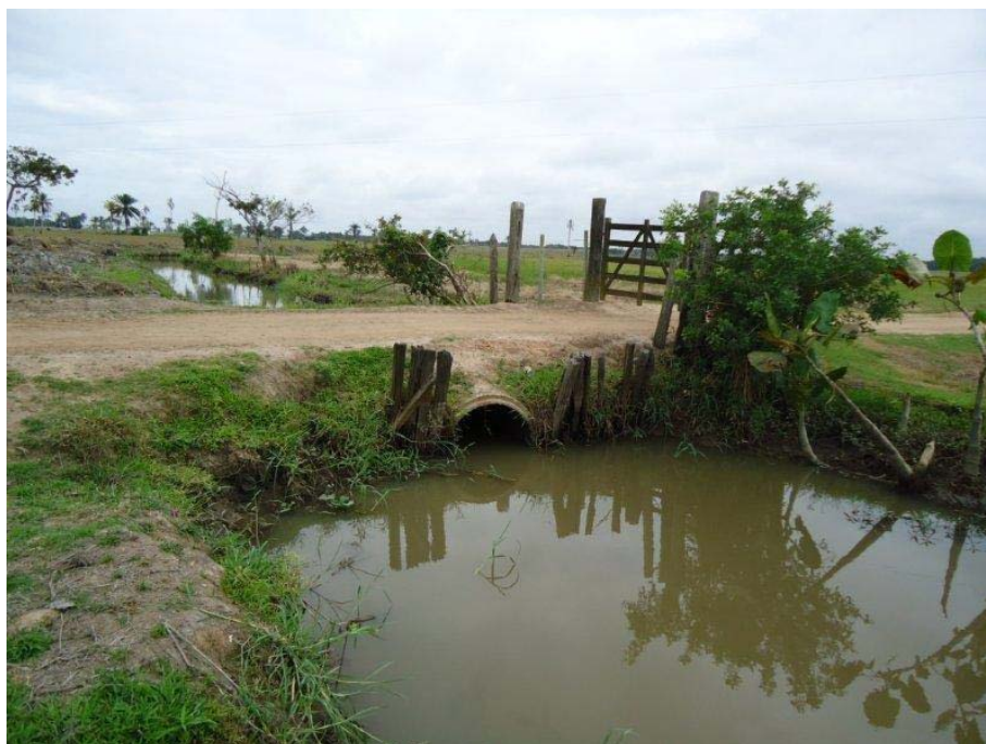
Foto 2.1.4.3-52 -P23 e P23-2 - 417237/7931832 – Canais de drenagem típicos das propriedades rurais da região, na margem esquerda do rio São Mateus, em Lage, ao sul da APA.
