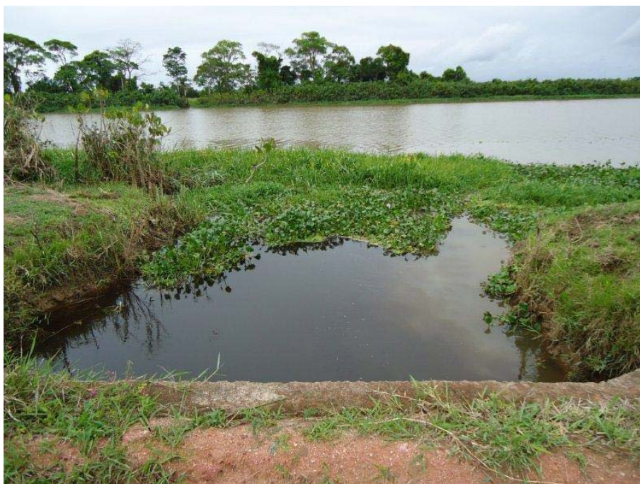
Foto 2.1.4.3-37 - P12-3 - 413015/7933613 – Foz do córrego da Represa, afluente do rio São Mateus, próximo ao limite sudoeste da área da APA e bueiro para passagem do canal sob rodovia não pavimentada.
