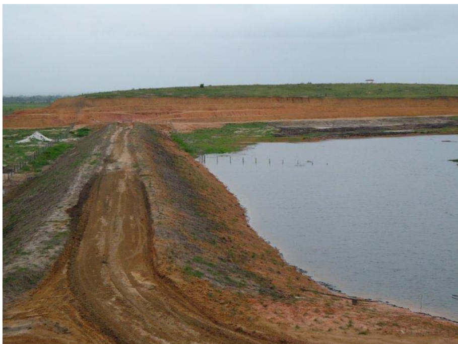
Foto 2.1.4.3-41 - P51 e P51-2 - 414412/7935109 - Córrego da Represa e barramento em construção, imediatamente a montante da APA, em propriedade rural.
