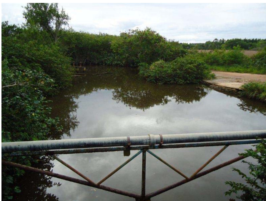
Foto 2.1.4.3-2 - P36 - 421202/7946890 – Córrego São Domingos, a jusante da ponte da rodovia Adolpho Serra.
