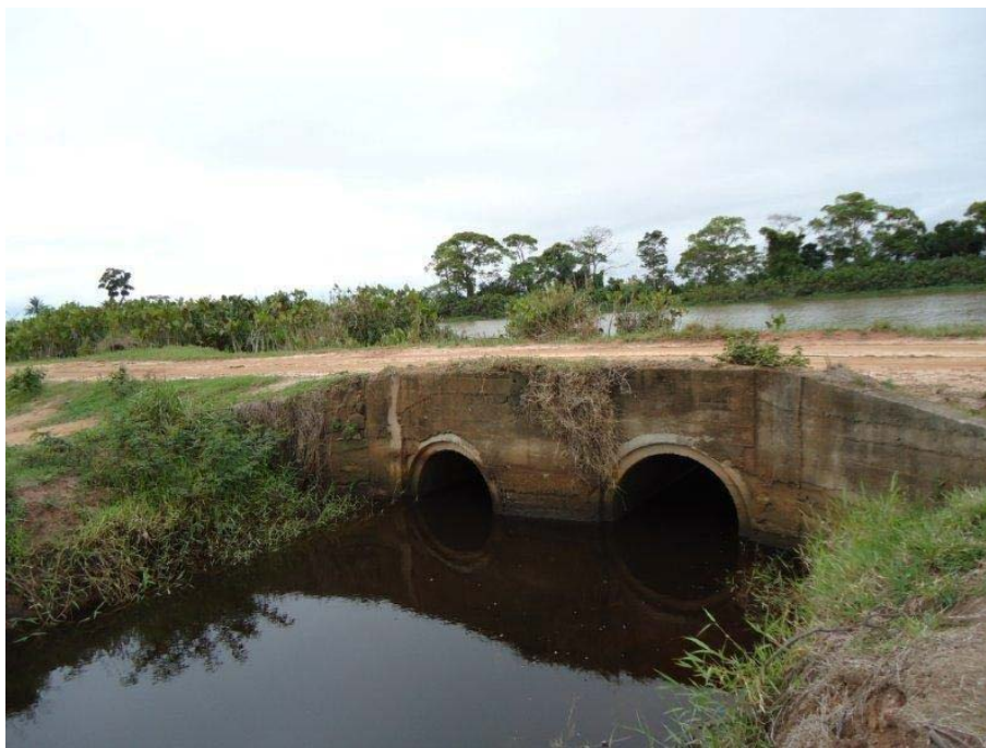
Foto 2.1.4.3-36 - P12-3 - 413015/7933613 – Foz do córrego da Represa, afluente do rio São Mateus, próximo ao limite sudoeste da área da APA e bueiro para passagem do canal sob rodovia não pavimentada.
