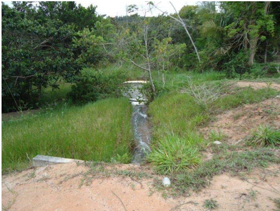
Foto 2.1.4.3-20 - P57-4 - 413217/7936724 – Barramento no Córrego Canivete, a montante da APA. Barragem com tubulação e calha vertedora.
