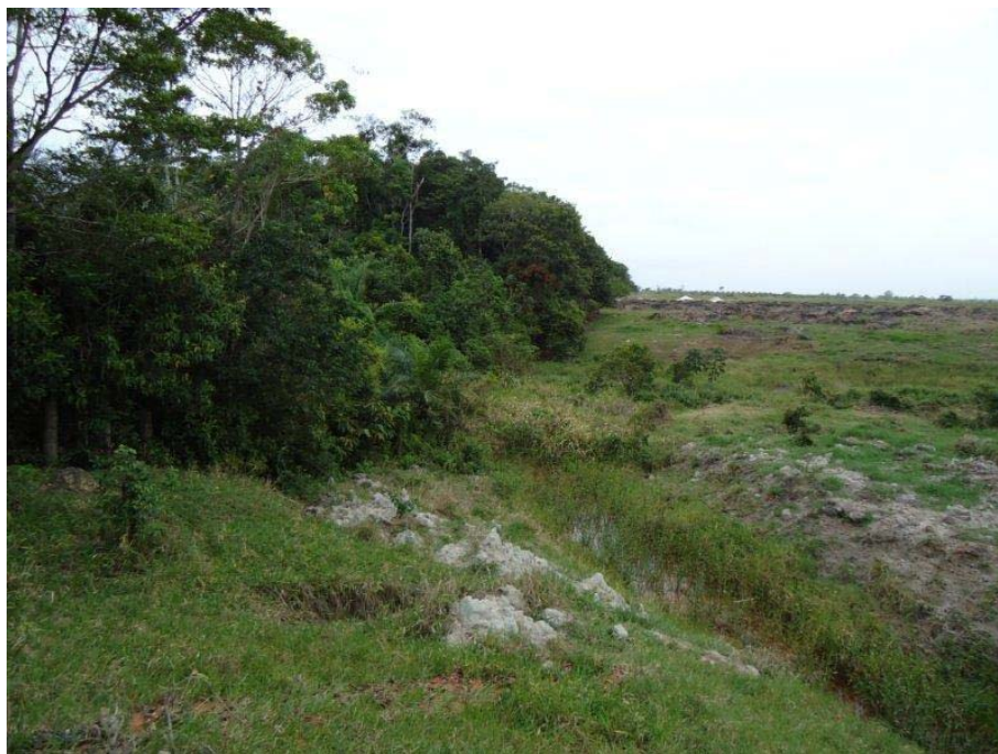
Foto 2.1.4.3-44 - P51 e P51-2 - 414412/7935109 - Córrego da Represa e barramento em construção, imediatamente a montante da APA, em propriedade rural.
