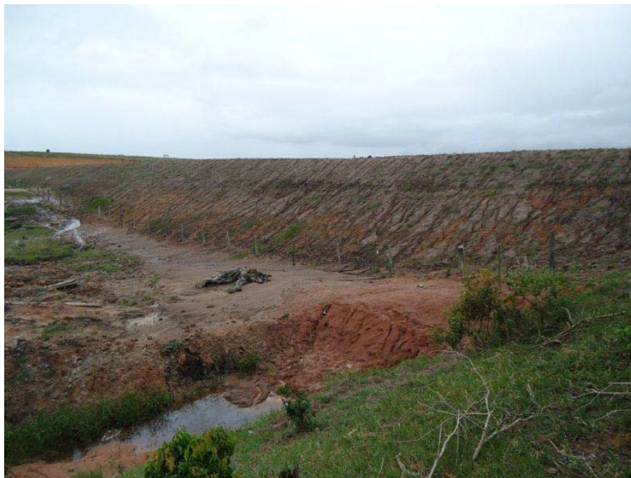
Foto 2.1.4.3-43 - P51 e P51-2 - 414412/7935109 - Córrego da Represa e barramento em construção, imediatamente a montante da APA, em propriedade rural.
