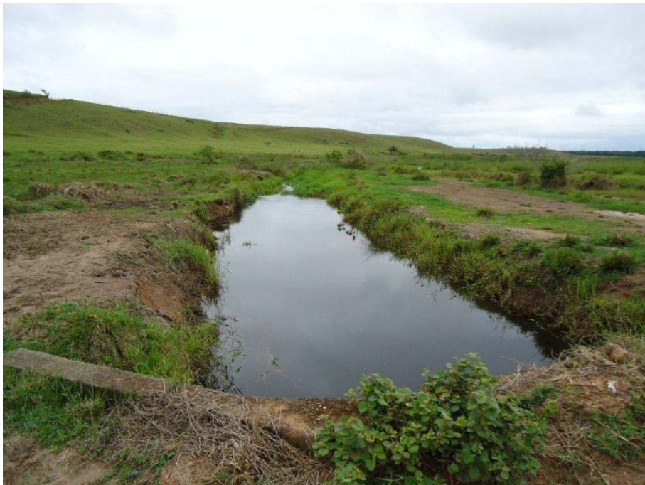
Foto 2.1.4.3-35 - P12-3 - 413015/7933613 – Foz do córrego da Represa, afluente do rio São Mateus, próximo ao limite sudoeste da área da APA e bueiro para passagem do canal sob rodovia não pavimentada.
