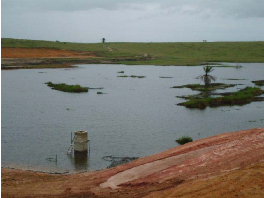
Foto 2.1.4.3-42 - P51 e P51-2 - 414412/7935109 - Córrego da Represa e barramento em construção, imediatamente a montante da APA, em propriedade rural.
