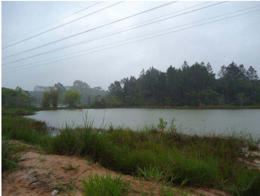
Foto 2.1.4.3-23 - P52 e P52-2 - 410665/7935555 - Represamento do córrego Canivete por plataforma da rodovia ES422, a montante da APA.
