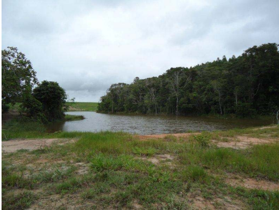
Foto 2.1.4.3-19 - P57-4 - 413217/7936724 – Barramento no Córrego Canivete, a montante da APA. Barragem com tubulação e calha vertedora.
