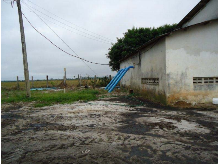
Foto 2.1.4.3-73 - P14 - 414646/7933456 – Casa de bombas de sistema de irrigação em área de plantação de coqueiros ao sul da APA.
