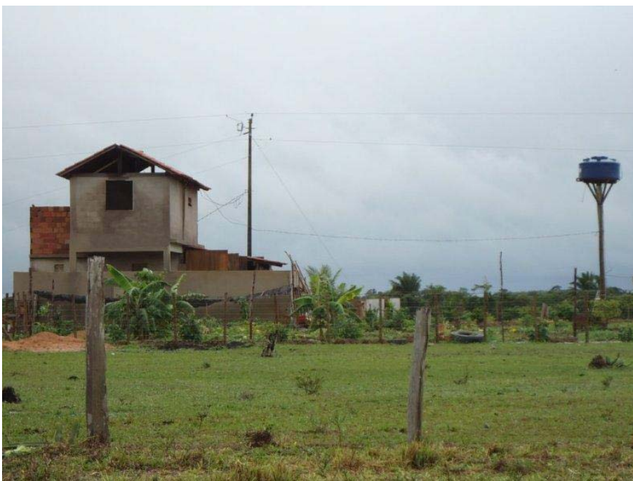
Foto 2.1.4.3-80 - P28-3 - 417065/7935136 - Residências abastecidas por poços freáticos
