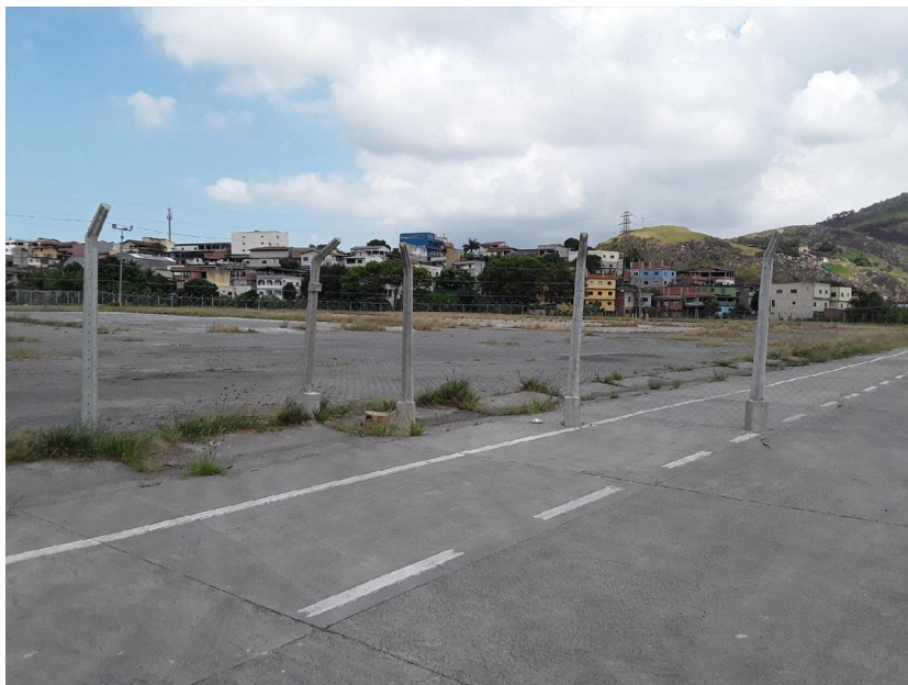
Foto 01: Vista geral da área de instalação dos tanques.
