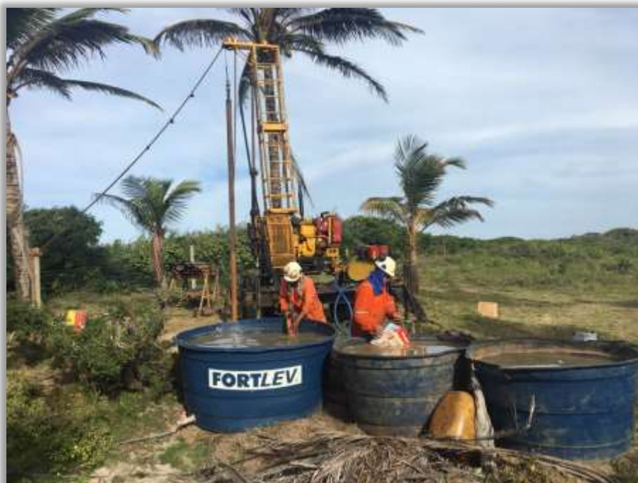
Figura 1.3 – Execução de Sondagem Mista
