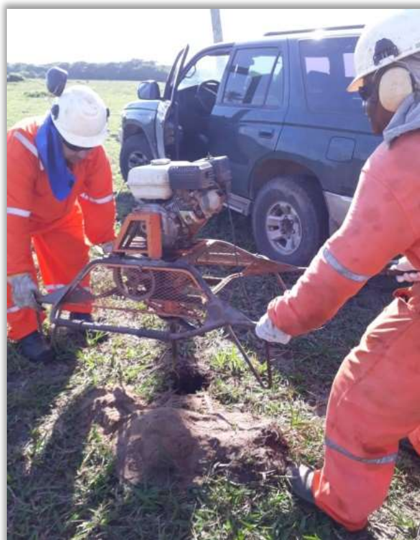
Figura 1.4 – Sondagem à trado
