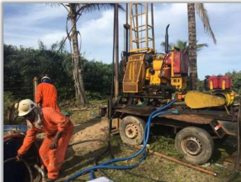
Figura 4.2.1 – Máquina de Sondagem e acessórios
