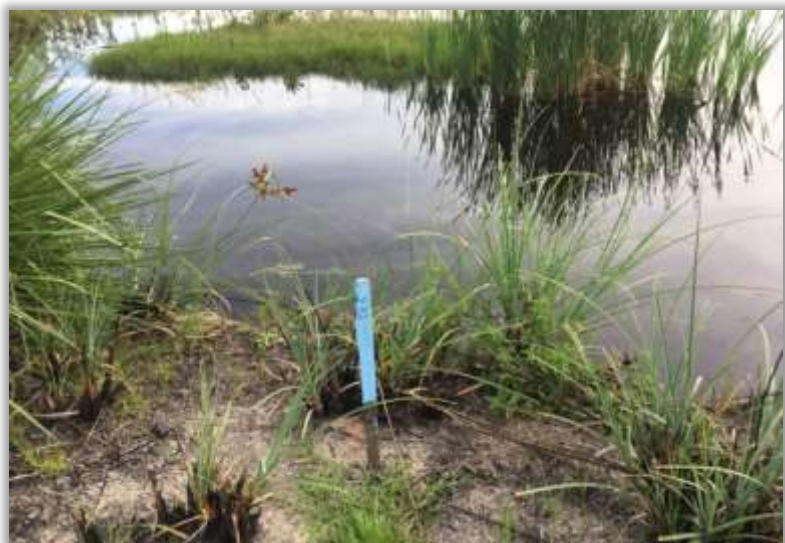
Figura 1.2 – Cravação de Estaca no Ponto de Sondagem
