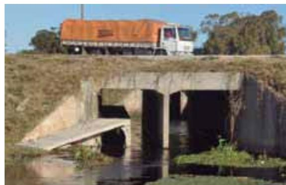
Figura 130 - Rampa de acesso no interior da galeria projetada para drenagem, favorecendo a travessia da fauna.
