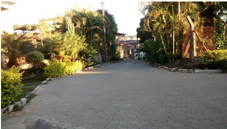
Figura 19- Calçamento da Rua José Alves da Silva, obra conquistada no Orçamento Participativo pela fusão da Vila Oásis ao Bairro Tucum
