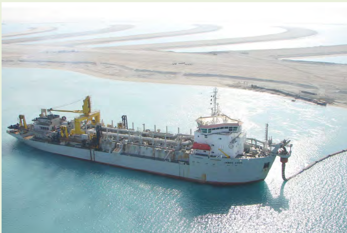
Figura 5.3.2.7-13: Exemplo do sistema de acoplamento para bombeamento de sedimentos.
