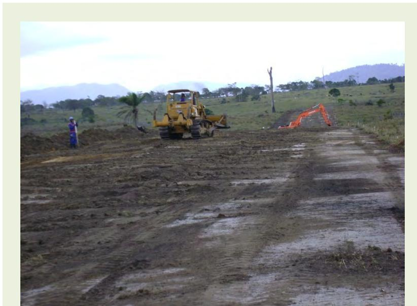
Figura 12.7-5: Exemplo de Trecho de Obra, com abertura de faixa.
