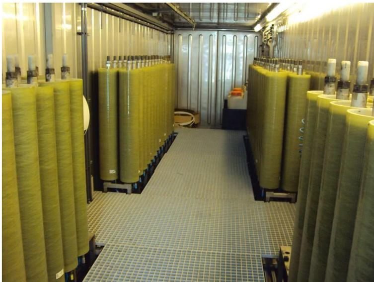
**Figura 3-73:** Vista interna do container metálico do sistema de Osmose Reversa e dos cartuchos de filtração.
