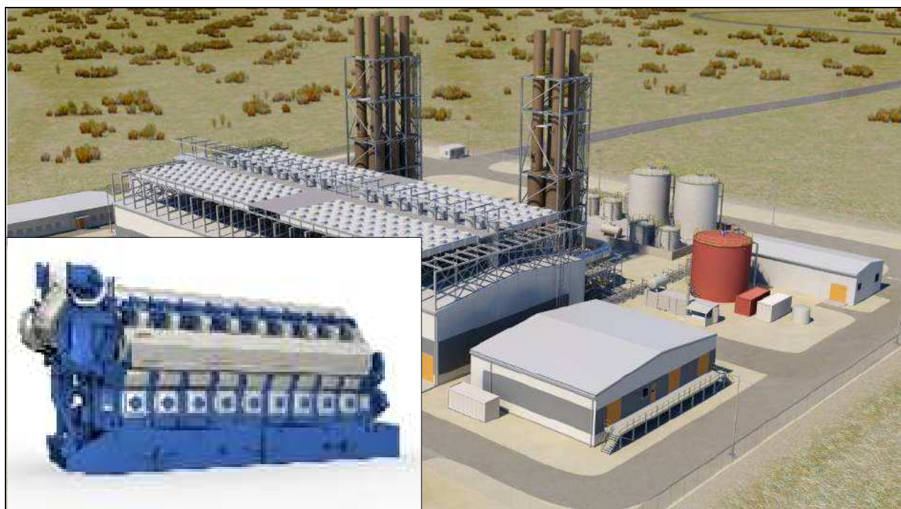
Figura 55 – Exemplo de uma Unidade de 168 MW compostos de 9 motogeradoras “Wärtsilä 18V50SG” cada.
