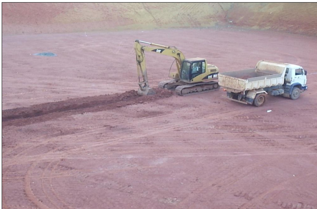
Figura 6.4-1 – Modelo de célula recém escavada, destacando a drenagem de chorume.
