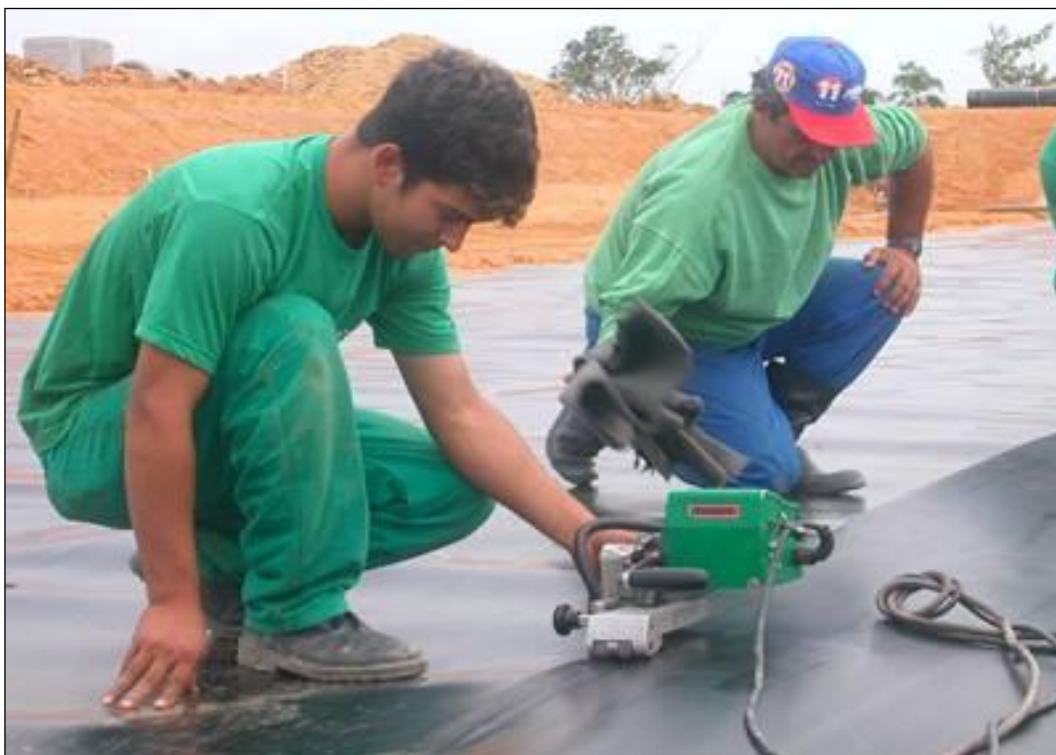
Figura 6.4-3 – Exemplo de soldagem da manta de PEAD
