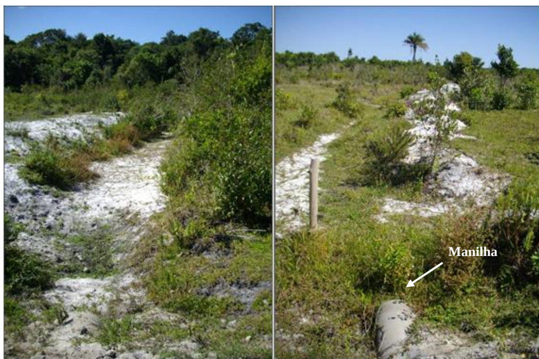
Figura 8.1-32 – Canal de derivação do Córrego Aimirim (Foto à esquerda ao fundo vegetação ripária do Córrego Aimirim; foto à direita prolongamento do canal em direção à área 2).
