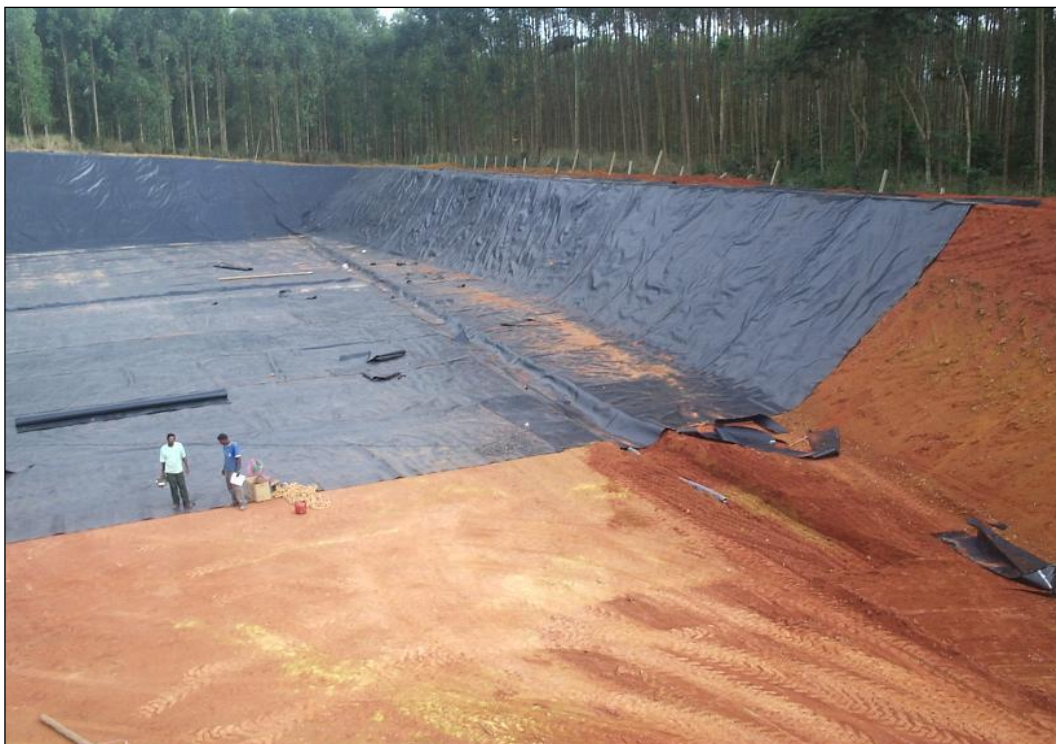
Figura 6.4-2 – Exemplo de instalação da manta de PEAD em célula, similar ao que será na Central de Tratamento de Resíduos de São Mateus
