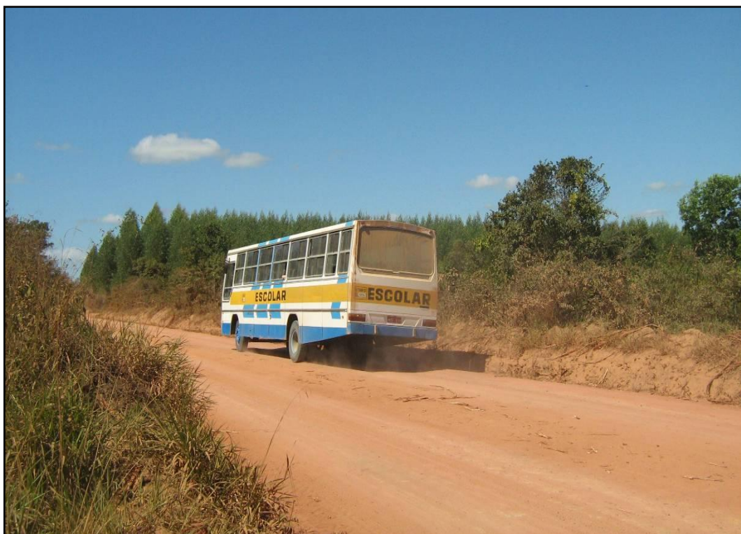
Figura 8.3-2 - Transporte escolar na ES 313, sem pavimentação
