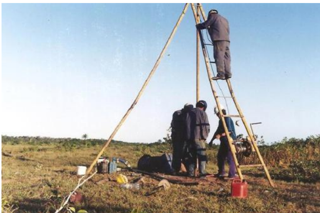
Figura 8.1-14 - Realização dos trabalhos de sondagem SPT – momento de sacar as hastes
