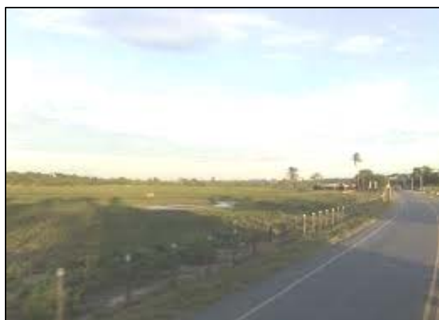
Figura 7.3.7.2-2: Rodovia ES-381 – chegada a São Mateus
