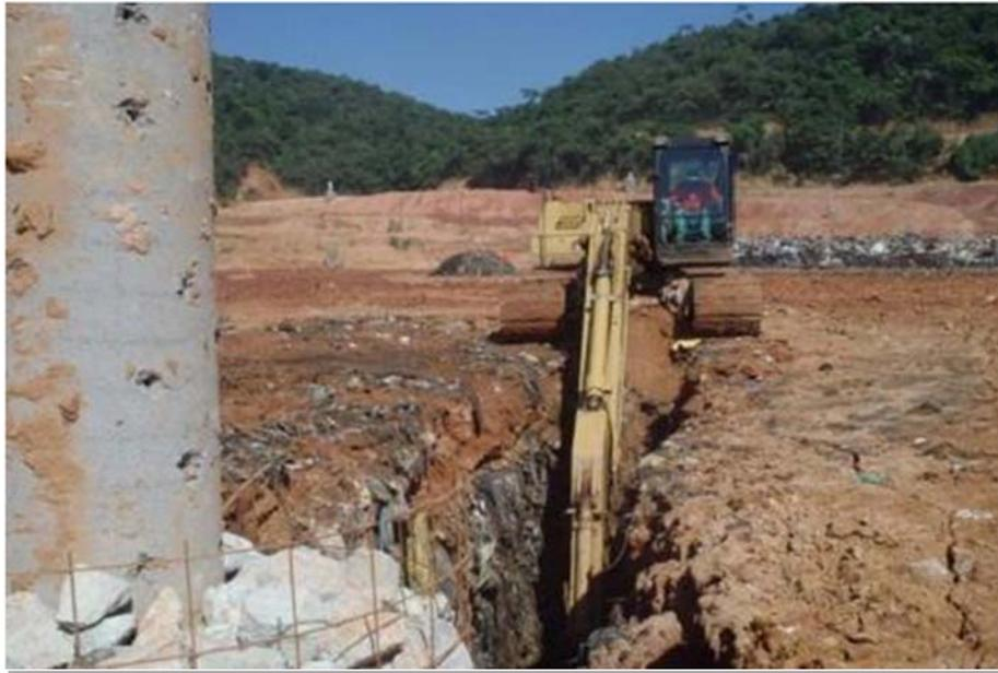
**Figura 6.11.4.4-3.** Exemplo de escavação do maciço de resíduos para implantação de dreno horizontal de chorume.
