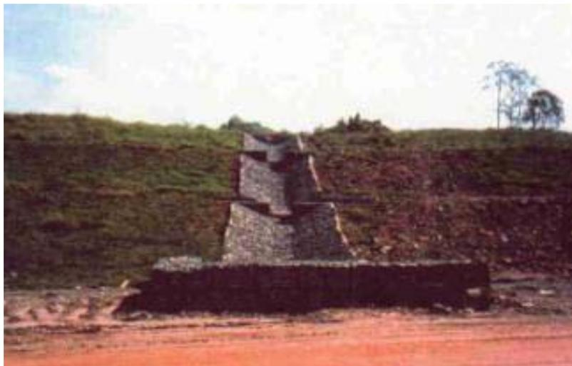
**Figura 6.11.4.3-7.** Descida d'água em colchão reno.
