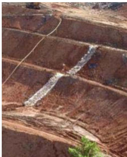
**Figura 6.11.4.3-2.** Drenagem provisória com sacos de areia em talude provisório.
