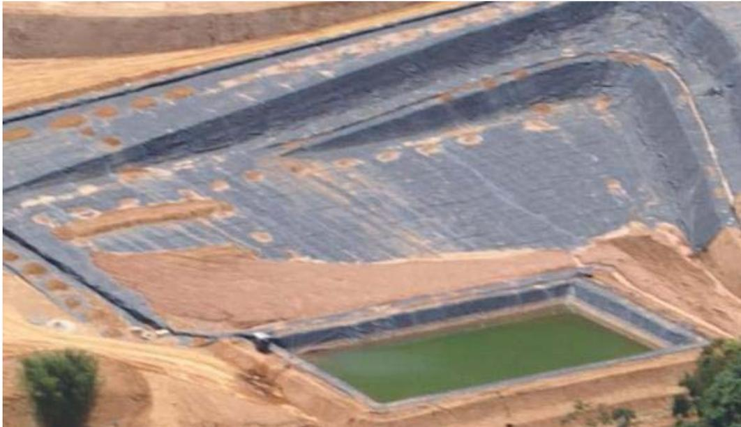
**Figura 6.11.4.1-3.** Geomembrana lançada na fundação de um aterro sanitário, apresentando uma camada de proteção mecânica parcialmente implantada.
