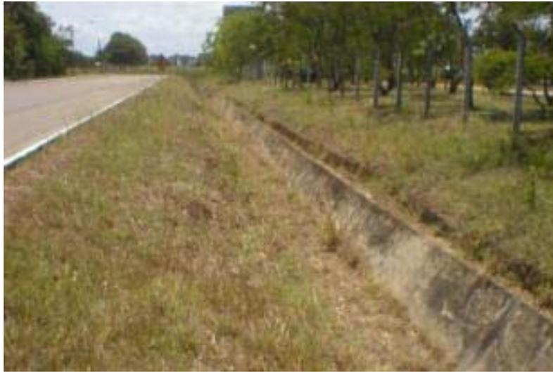
**Figura 6.11.4.3-6.** Canaleta lateral de drenagem em concreto.
