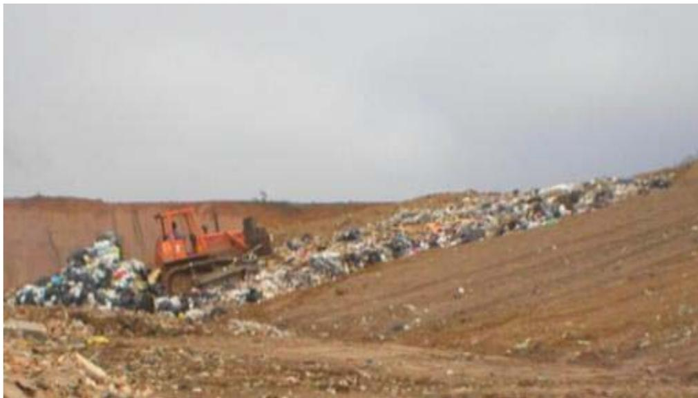
**Figura 6.11.1-2.** Exemplo de lançamento e compactação de resíduos em um aterro sanitário.
