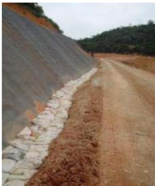
**Figura 6.11.4.3-1.** Drenagem provisória com sacos de areia na estrada de acesso ao lado da geomembrana.
