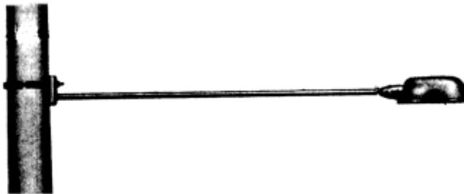
**Figura 5-366:** Luminária instalada em braço com inclinação vertical nula.
