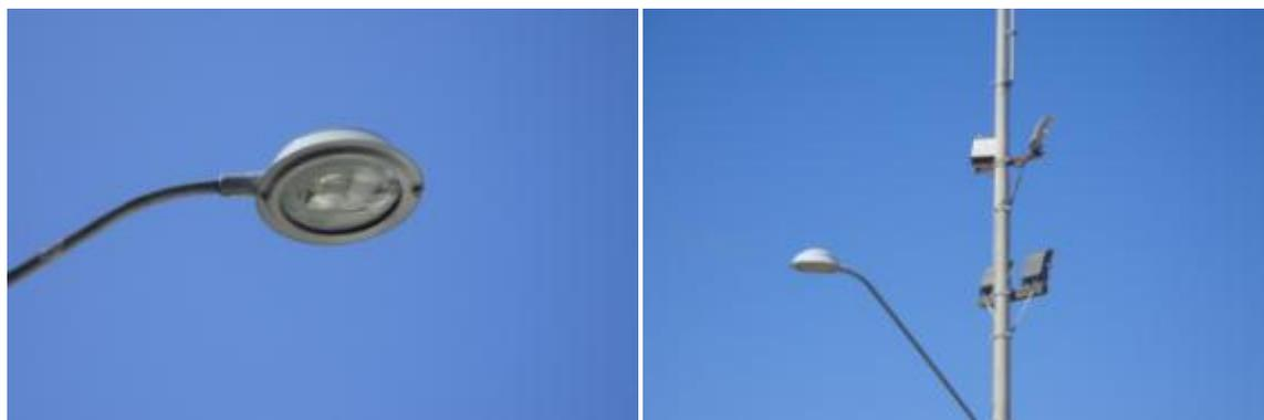
**Figura 5-381:** Detalhe da luminária do tipo pétala e do refletor de alta potência utilizados na área industrial do canteiro de obras instalado no porto organizado de Barra do Riacho, a nordeste do Estaleiro Jurong Aracruz.
