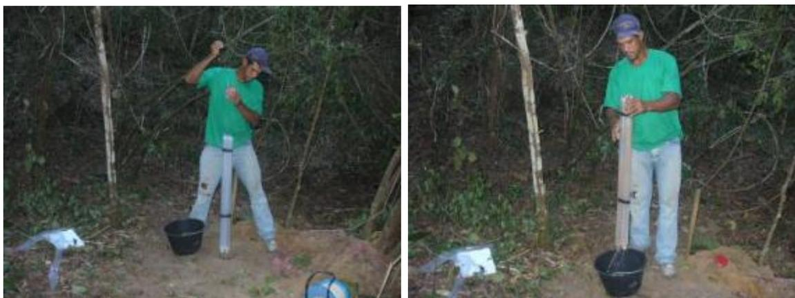
**Figura 5-198:** Imagens da limpeza dos poços após a perfuração.
