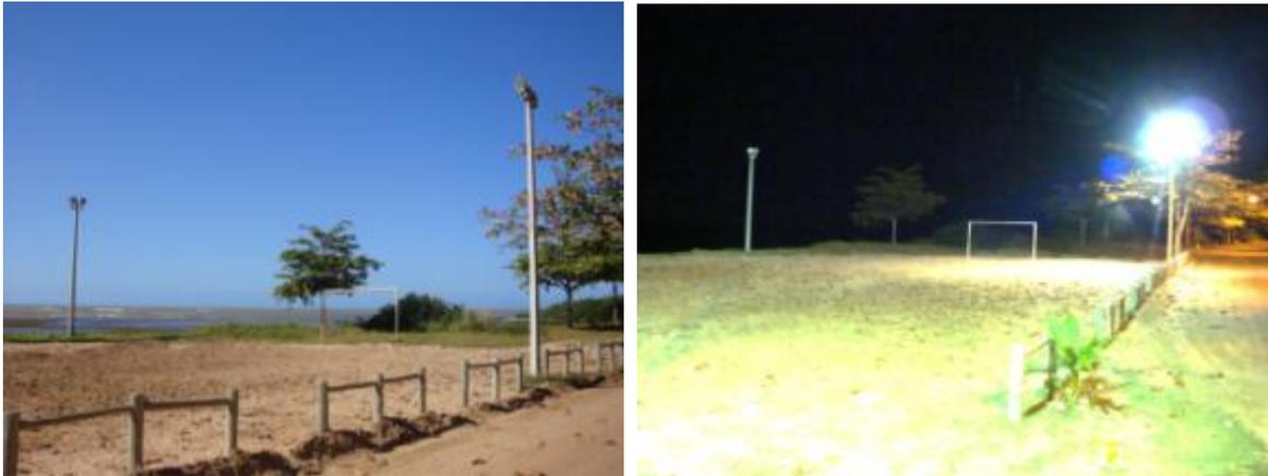
**Figura 5-371:** Sistema de iluminação de Mar Azul, no trecho litorâneo, numa área de prática esportiva, formado por luminária tipo pétala e refletor de alta potência, com lâmpada multi vapor metálica.
