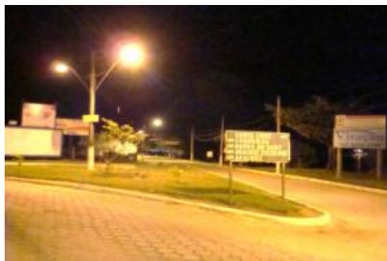
**Figura 5-367:** Sistema de iluminação do trevo de Santa Cruz, composto por luminárias fechadas com refrator prismático e lâmpada a vapor de sódio de alta pressão.
