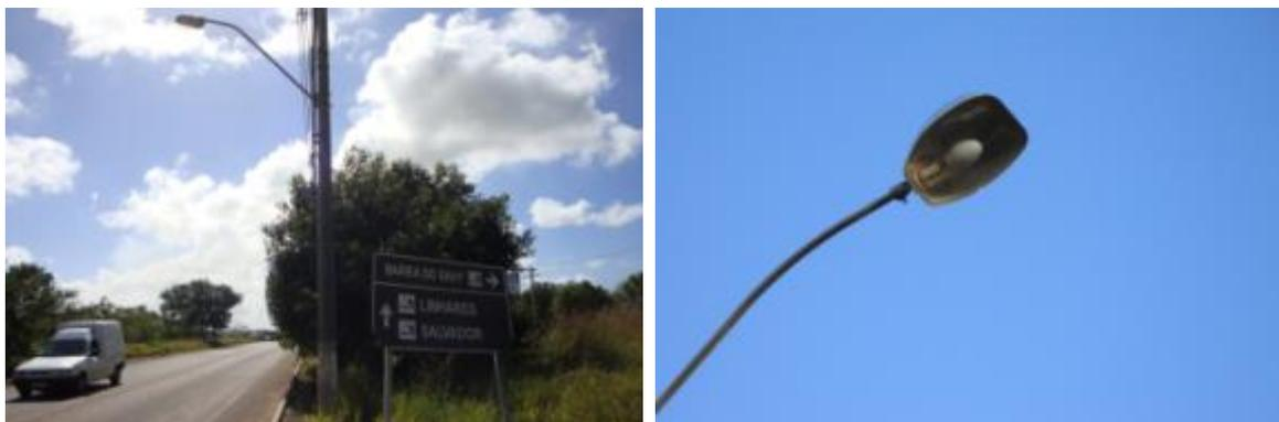
**Figura 5-358:** Sistema de iluminação formado por luminária do tipo aberta estampada, com detalhe da luminária.
