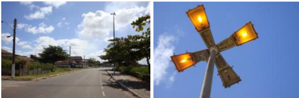
**Figura 5-362:** Sistema de iluminação formado por luminária tipo pétala com refrator prismático, com detalhe da luminária.
