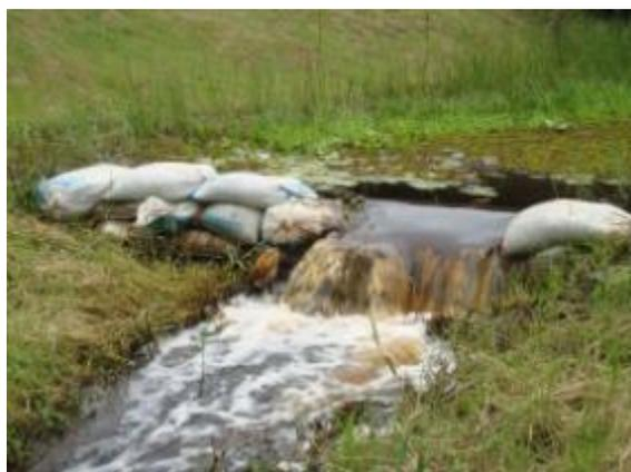
**Figura 5-173:** Pequena barragem no córrego Guaxindiba, feita para facilitar a captação para o SAA de Barra do Sahy.
