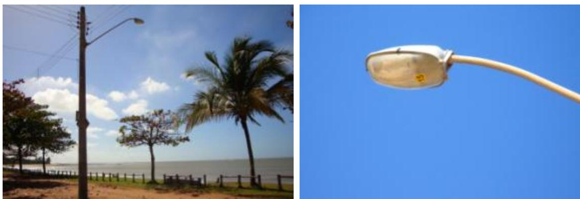
**Figura 5-360:** Sistema de iluminação formado por luminária fechada com refrator prismático, com detalhe da luminária.
