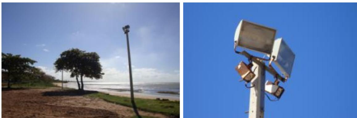
**Figura 5-363:** Sistema de iluminação formado por luminária tipo pétala com refrator prismático, com detalhe da luminária de alta potência.
