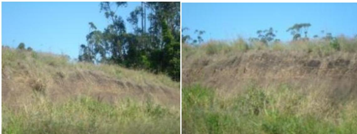
**Figura 5-284:** Taludes verticais resultantes de cortes nos Tabuleiros Costeiros para implantação de estrada estadual que passa no perímetro da área de implantação do empreendimento. Observa-se a boa estabilidade destes taludes.
