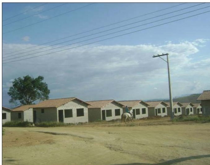
Figura 7.3.5.1-1: Casas populares no bairro, em construção.
