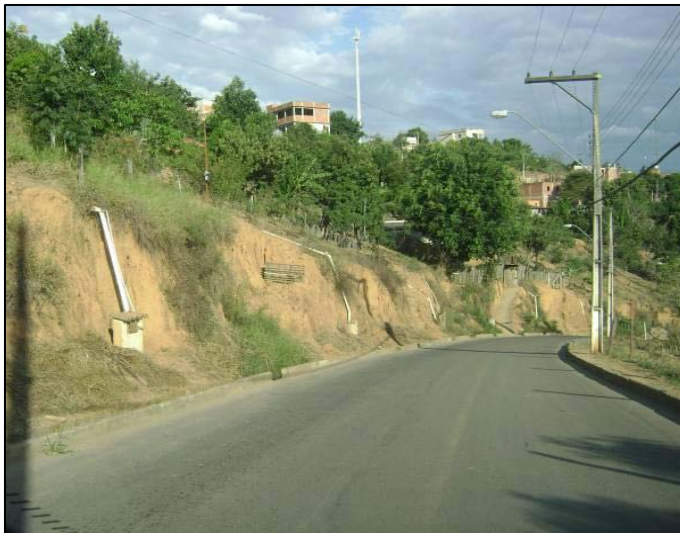
Figura 7.3.2.1-1: Acesso ao bairro, direção da ES 080. Notam-se as ligações de esgoto nas residências.
