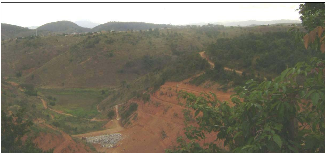
Figura 7.3.3.1-1: Foto da Central de Tratamento com seus limites, mostrando o uso e ocupação das terras do entorno. Podemos observar as áreas de pastagens e mais ao fundo as residências limites do bairro Ayrton Senna.
