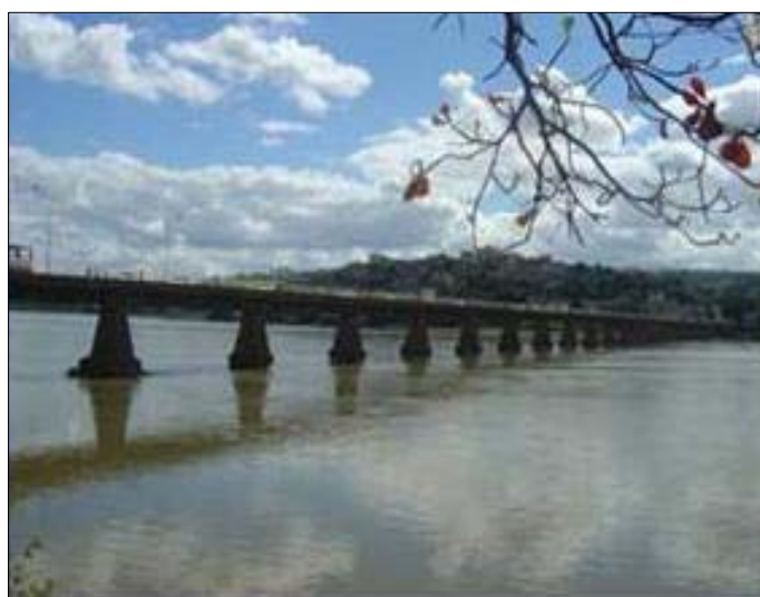
Figura 7.3.12-4: Primeira Ponte de Colatina.
