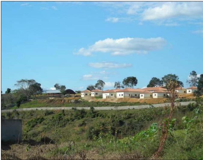
Figura 7.3.5.2-1: Escola em construção no bairro.
