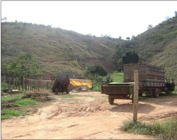
Figura 7.3.2.2-7: Aterro em construção, próximo ao acesso da Central de Tratamento de Resíduos.
