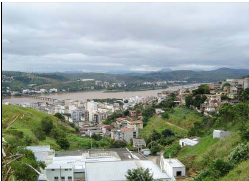
Figura 7.3.1-1: Ponte do município de Colatina.
