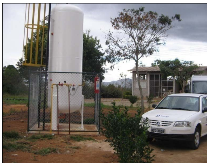
Figura 7.3.8-6: Estruturas implantadas no topo do morro para funcionamento do aterro.
