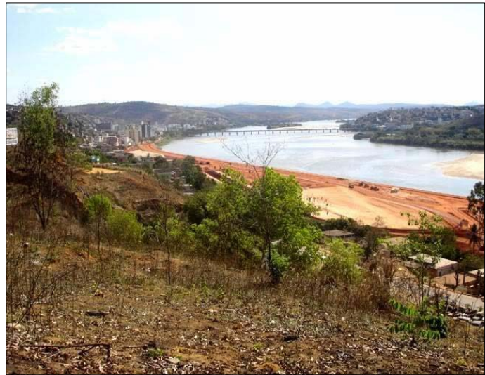
Figura 7.3.7.2-1: Foto das obras de ampliação da Avenida Beira Rio.
