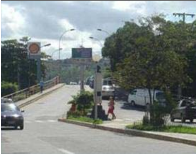
Figura 7.3.12-5: Acesso à Primeira Ponte de Colatina.
