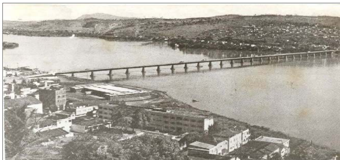
Figura 7.3.8-3: Ponte de Colatina.
