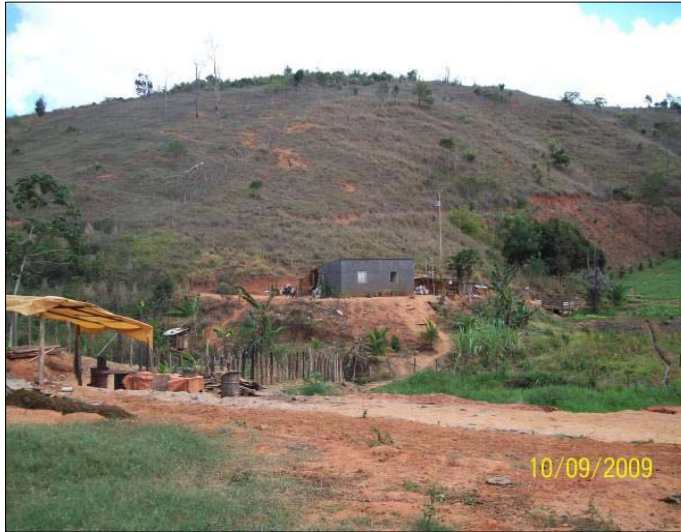
Figura 7.3.2.2-9: Foto do aterro em construção na frente e aos fundos o bairro.
