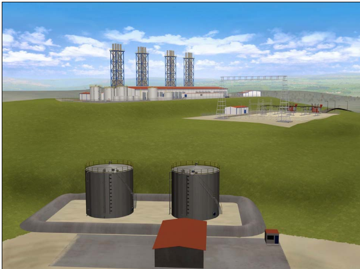
Figura 2.2-1: Vista dos tanques de armazenamento de 2500 m 3 .
