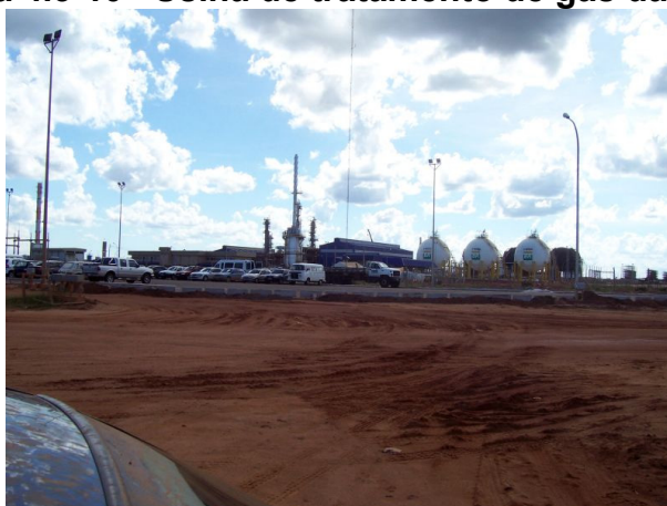
Fotografia 4.3-10– Usina de tratamento de gás da Petrobrás
