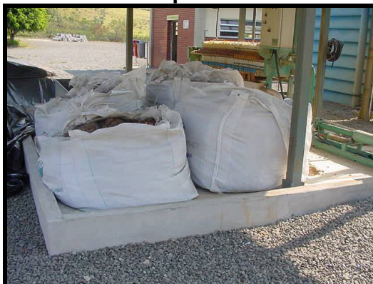
Foto 5.3-01 – Exemplo de local para armazenamento de embalagens com o resíduo sólido proveniente da ETA.
