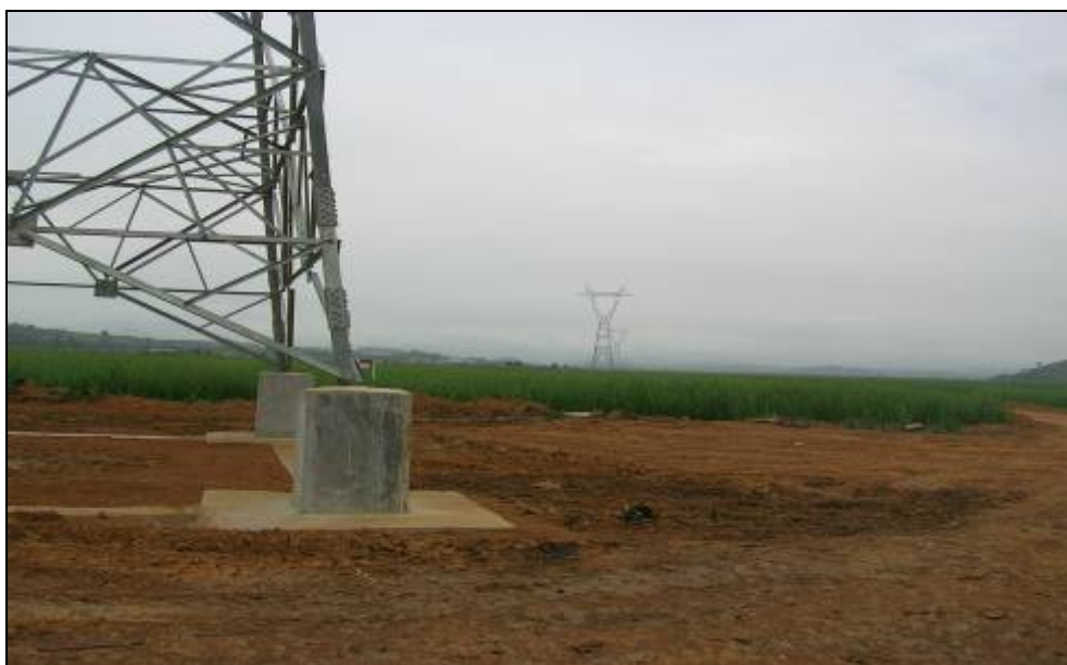
Figura 3.3.3.5-2: Detalhe da vista da área do empreendimento. Observar aterro para implantação da torre e via de acesso referentes a LT Ouro Preto - Vitória.
