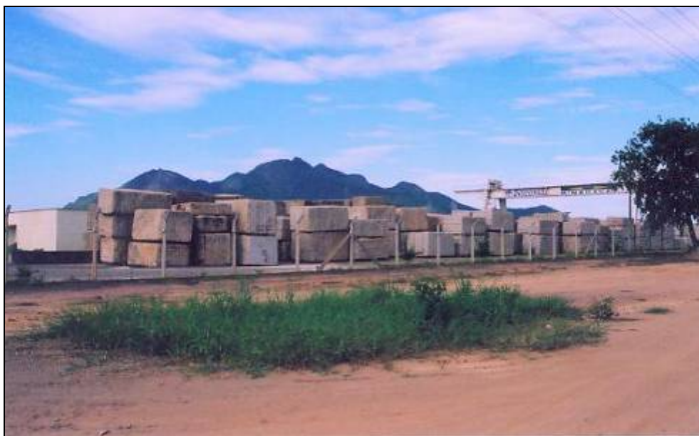
Figura 3.3.2.2-2: Vista das instalações da Empresa Tracomal no entorno do Pólo Industrial Jacuhy. Fonte: CEPEMAR (2005).
