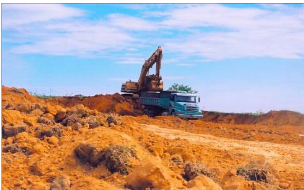
Figura 3.1.4.5-1: Ilustração da área de ocorrência de Latossolos, utilizada como área de empréstimo, devidamente licenciada pelo IEMA, no interior do Pólo Industrial Jacuhy .
