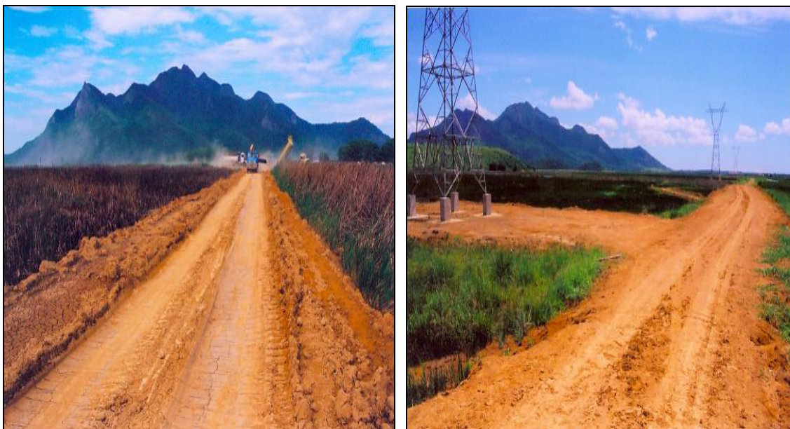
Figuras 3.2.2.3-5 e 3.2.2.3-6: Aterro na imensa planície alagada para a construção de novas estradas de acesso para as futuras torres da Linha de Transmissão de Furnas (Ouro Preto – Vitória). Fotos © J. L. Gasparini.
