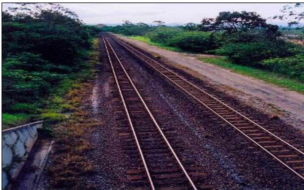
Figura 3.1.2.3-2: Vista da Estrada de Ferro Vitória-Minas no entorno do Pólo Industrial Jacuhy, em área de ocorrência do Grupo Barreiras.
