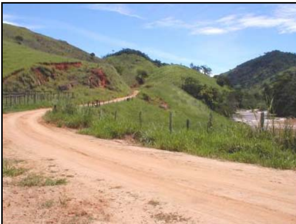
FIGURA 4.1.3.4 - Terra Roxa Extruturada próximo ao eixo da Barragem de Derivação.
